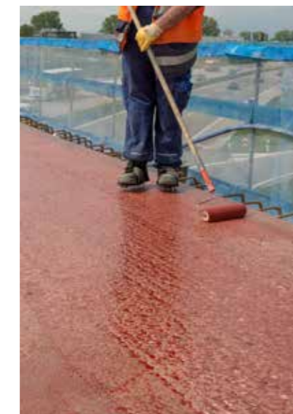
Nachrollen mit einer Lammfellrolle
