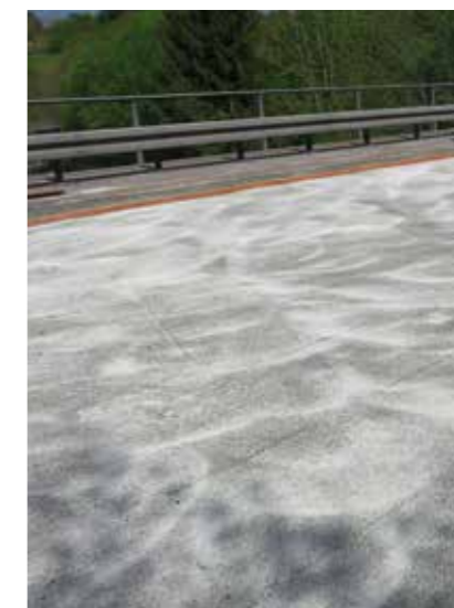
Abgestreute Fläche mit Sikalastic®-827 HT
