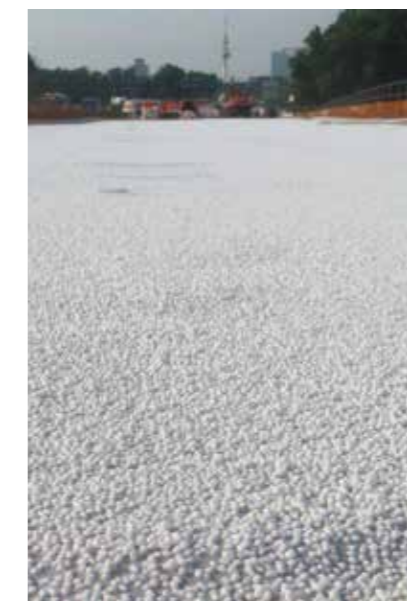
Klebeschicht mit Sikalastic®-827 HT
