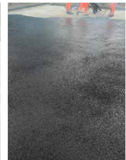
Einbau der Gussasphalt-Schutzschicht
