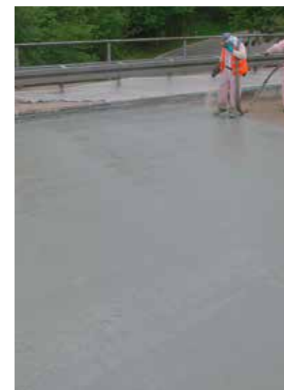
Applikation der Dichtungsschicht
