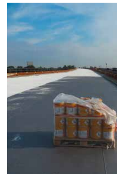
Auftrag der Grundierung und Haftschicht
