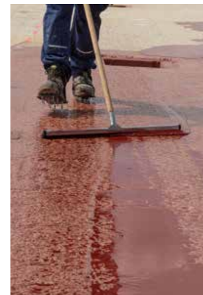
Auftrag mit einem Moosgummischieber
