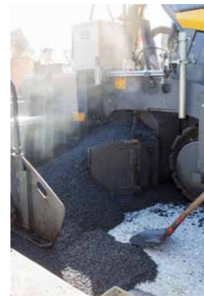
Einbau des Asphalt-Traggerüsts
