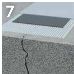
7 Abdichtung von Rissen
