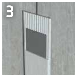
Fugen bei Fertig- teilelementen
