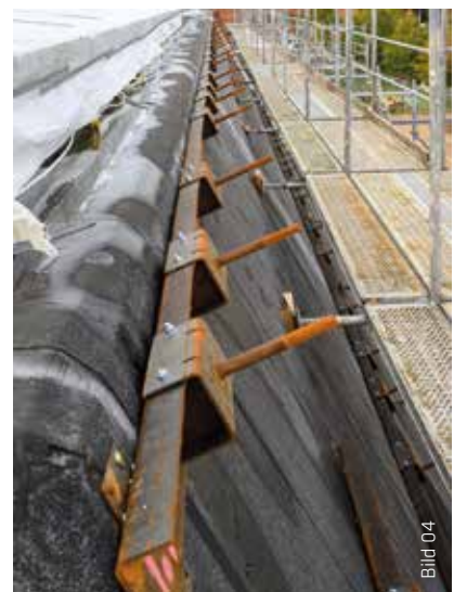
Ansicht der Stahlunterkonstruktion auf der Dampfsperrebene.
