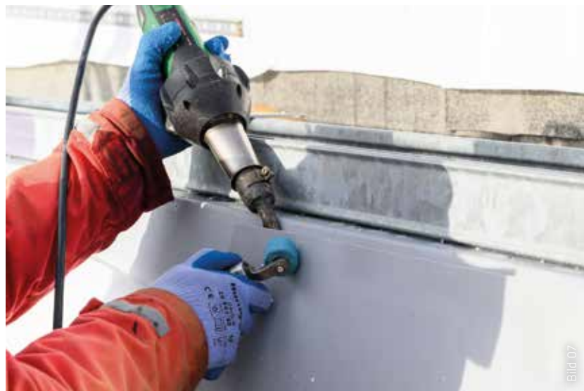
Die Dachneigung von 66 Grad und der enge Arbeitsraum erfordern eine manuelle Verschweißung der Sarnafil-Abdichtungsbahnen.
