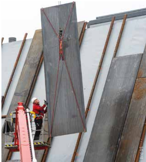
Die Cortenstahlplatten werden in das fertig abgedichtete Dach eingehängt.
