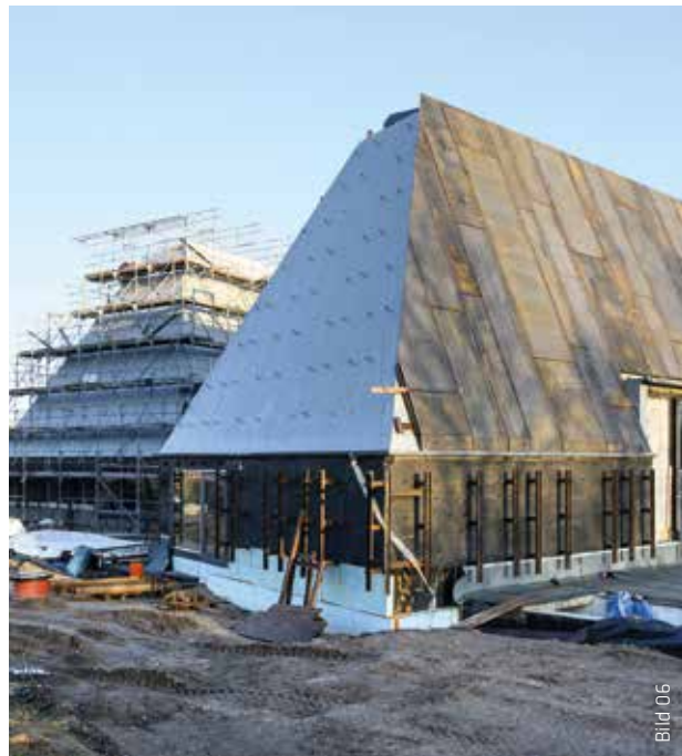
Die neuen Gebäude des Freilichtmuseums Molfsee erinnern an die historischen Scheunen Schleswig-Holsteins. Die Cortenstahlplatten auf den Dächern nehmen durch die Bewitterung später eine rostbraune Farbe an – ähnlich der im Norden traditionellen Dacheindeckungen mit Reet.
