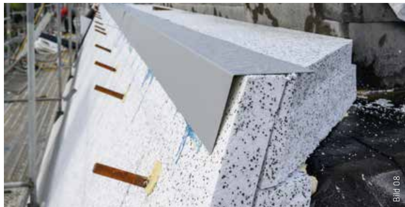
Auf der bituminösen Dampfsperre sind Polystyrol-Dämmplatten montiert.
