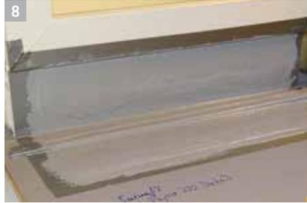
Bei der Applizierung der ersten Lage werden etwa 2/3 des Gesamtverbrauches pro m<sup>2</sup> eingesetzt.
