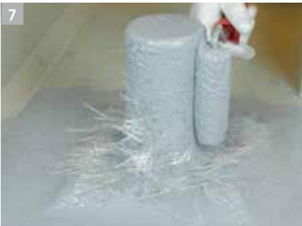
7 Applizieren der zweiten Lage. Dies entspricht etwa 1/3 des Gesamtverbrauches pro m<sup>2</sup>. Die Oberfläche sollte am Ende eine glänzende Optik aufweisen. Die Struktur der Vlieseinlage darf nicht mehr erkennbar sein.
