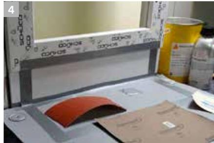
4 Untergrundvorbereitung durch bauseits geeignete Maßnahmen. Bsp. Hart PVC anschleifen mit Schleifpapier der Körnung P80 bis P120. Wichtig ist ein gleichmäßiges Schleifbild.
