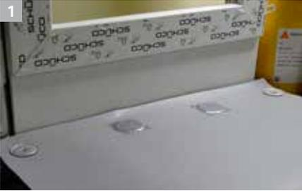
1 Anschluss Flächenabdichtung (z. B. Sikaplan® PVC-P) an Fensterelement Hart PVC.
