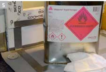
5 Schleifstaub entfernen / Oberflächen aktivieren z. B. durch Sikalastic® Rapid Reiniger.
