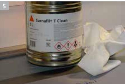
5 Schleifstaub entfernen/Oberflächen aktivieren z. B. durch Sarnafil® T-Clean oder Sikalastic® Rapid Reiniger.
