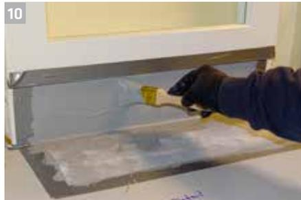
Applizieren der zweiten Lage. Dies entspricht etwa 1/3 des Gesamtverbrauches pro m<sup>2</sup>. Die Oberfläche sollte am Ende eine glänzende Optik aufweisen. Die Vliesstruktur ist nicht mehr zu erkennen.
