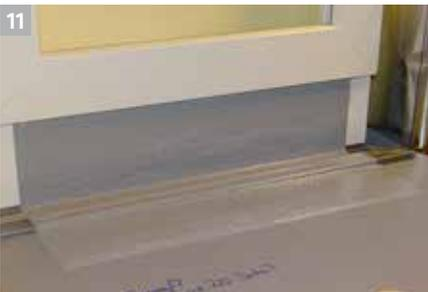
Klebeband entfernen bevor Hautbildung Sikalastic® Rapid-722/-722 Detail beginnt.
