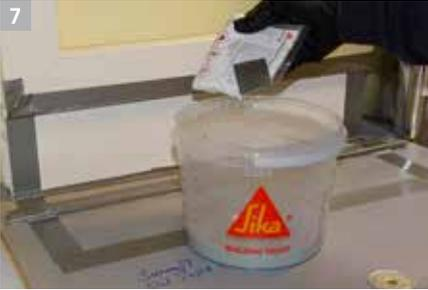
Anmischen der benötigten Menge Sikalastic® Rapid-722 /722 Detail mit Sikalastic® Rapid KATpulver gemäß Katalysatordosierungsempfehlung auf S. 58.
