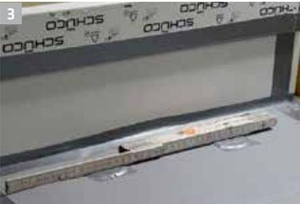
3 Abdichtenden Bereich mit Klebeband abgrenzen, Tellerbefestiger mit Klebeband PE Oberfläche entkoppeln.
