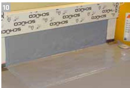
Klebeband entfernen bevor Hautbildung Sikalastic®-641 einsetzt.
