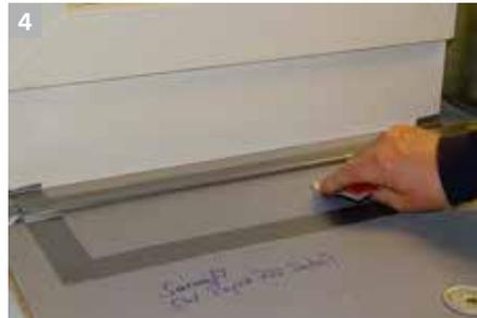
4 Untergründe vorbereiten: - z. B. Hart PVC anschleifen mit Schleifpapier der Körnung P80 bis P120 - z. B. Sarnafil® FPO PP anschleifen mit Schleifpapier der Körnung P60. Wichtig ist ein gleichmäßiges Schleifbild.
