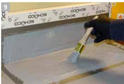
Applizieren der zweiten Lage. Dies entspricht etwa 1/3 des Gesamtverbrauches pro m<sup>2</sup>. Die Oberfläche sollte am Ende eine glänzende Optik aufweisen. Die Struktur des Sikalastic® Fleece-200 darf nicht mehr erkennbar sein.
