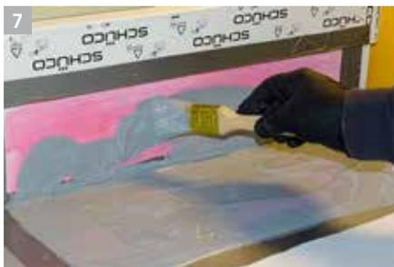
Zuschnittene Sikalastic® Fleece-200 vorbereiten. Bei der Applizierung der ersten Lage werden etwa 2/3 des Gesamtverbrauches pro m<sup>2</sup> eingesetzt.
