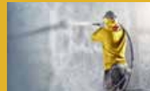
BETONSCHUTZ UND INSTANDHALTUNG
