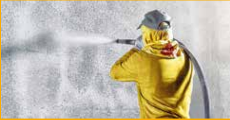
BETONSCHUTZ UND INSTANDHALTUNG
