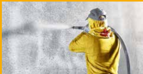
BETONSCHUTZ UND INSTANDHALTUNG
