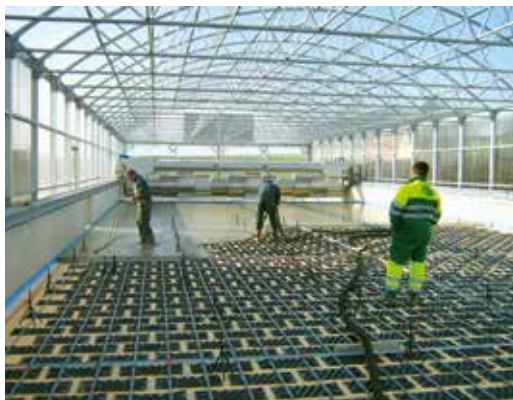
Höhere Verlegegeschwindigkeiten sind möglich
