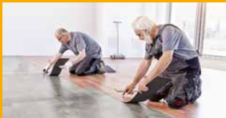
FLIESEN-, WAND- UND FUSSBODENTECHNIK
