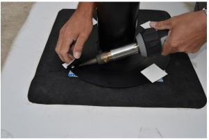
4. Flächenzuschnitt herstellen (Größe entsprechend der Öffnung 350 x 350 mm plus Überlappung) und mit der Dachabdichtung verschweißen.
