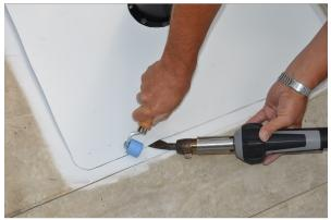
7. Rohreinfassung DN 125 über RSC-Rohr schieben und mit der Dachabdichtung verschweißen.
