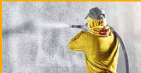
BETONSCHUTZ UND INSTANDHALTUNG
