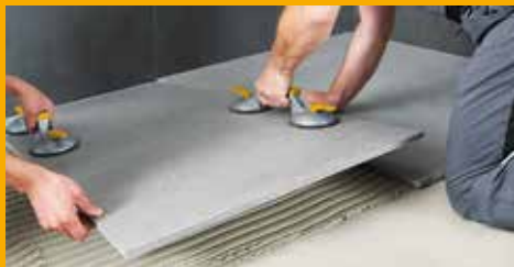
FLIESEN-, WAND- UND FUSSBODENTECHNIK
