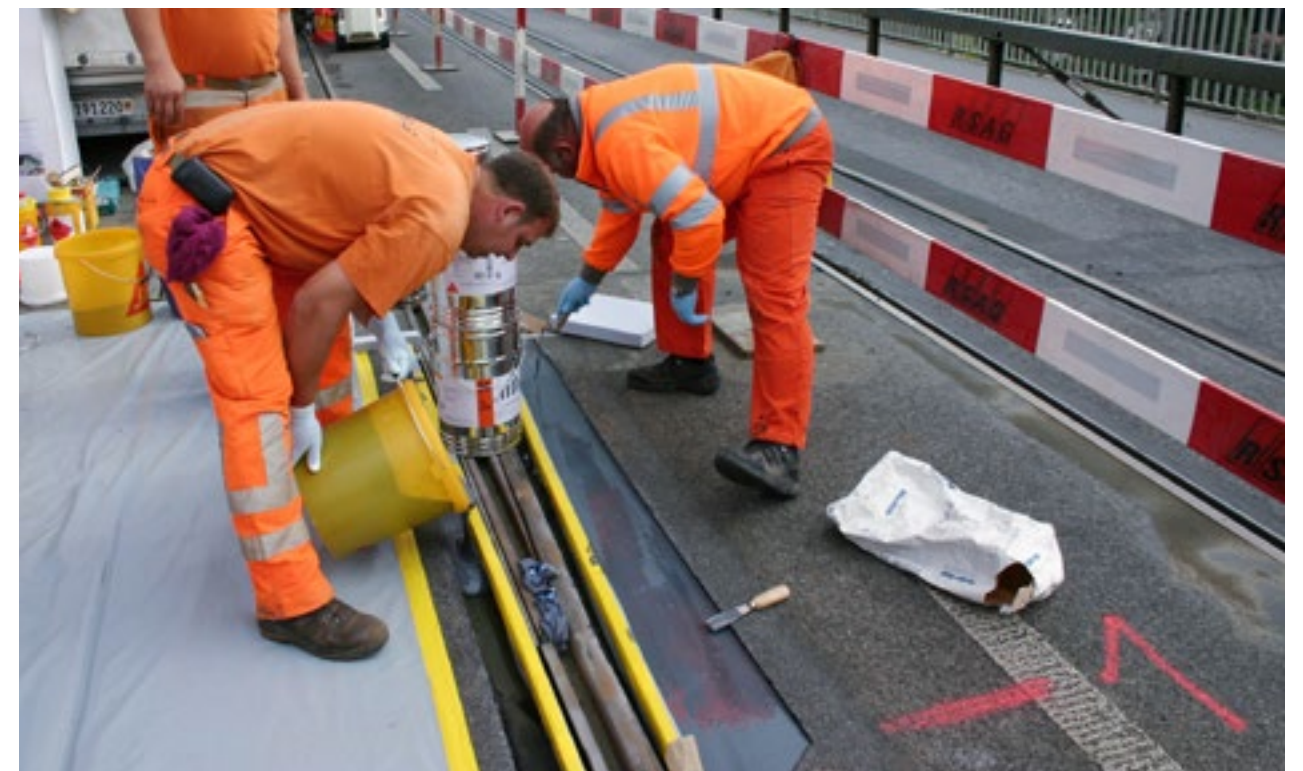
Kontinuierlicher Verguss von Rillenschienen
