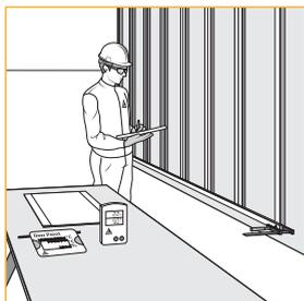
Beim Arbeiten mit Klebstoffen ist ein gut vorbereiteter, sauberer Arbeitsplatz wichtig. Markieren Sie genau, wo das erste Panel auf die Unterkonstruktion geklebt werden soll oder verwenden Sie einen auf der Unterkonstruktion befestigten Bezugspunkt. Dokumentieren Sie alle relevanten Informationen wie Datum, Temperatur, Luftfeuchte, Abluftzeiten usw.
