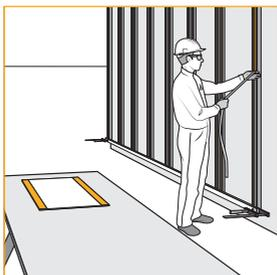
Schutzfolie des SikaTack® Panel Montagebands entfernen.
