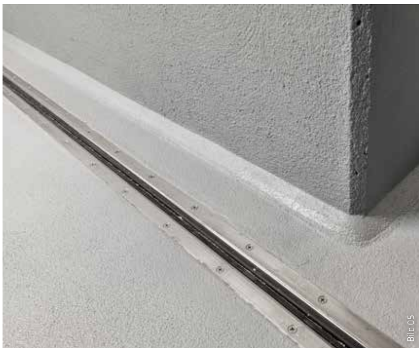
Bei der Sanierung der Tiefgarage wurden auch die Dehnungsfugen erneuert und die Sockelbereiche der Tiefgaragenstützen mit Sika Icoment-520 reprofiliert.
