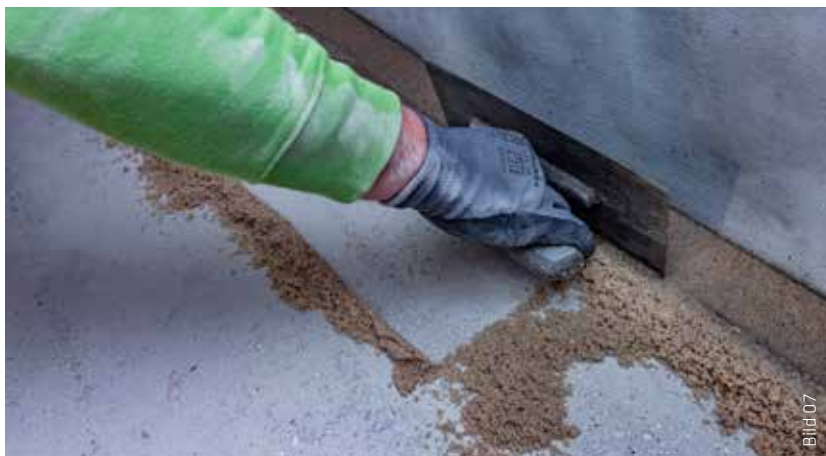
Die Reprofilierungsarbeiten an den Wandsockeln der Tiefgarage wurden mit dem bewährten Feinspachtel Sika Icoment-520 ausgeführt. Er ist speziell für OS-Systeme entwickelt.
