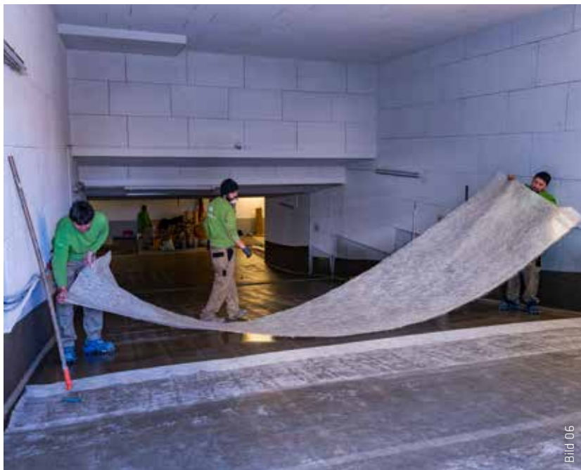
Das rissüberbrückende Glasfaservlies Sika Reemat Premium wird direkt in die noch frische Dichtungsschicht eingelegt.
