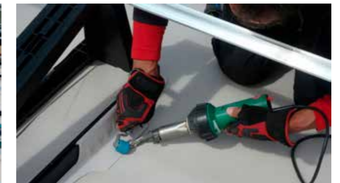
Heißluft-Verschweißung des Sika SolarClick
