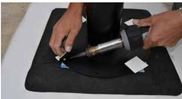
... und RCS-Rohr in den Untergrund befestigen
