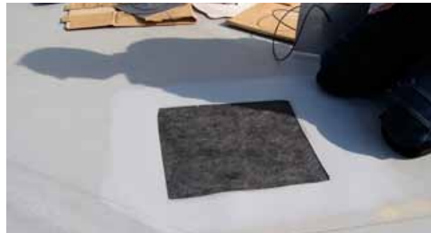
Vorbereitung zum Anbringen der Kontaktplatte
