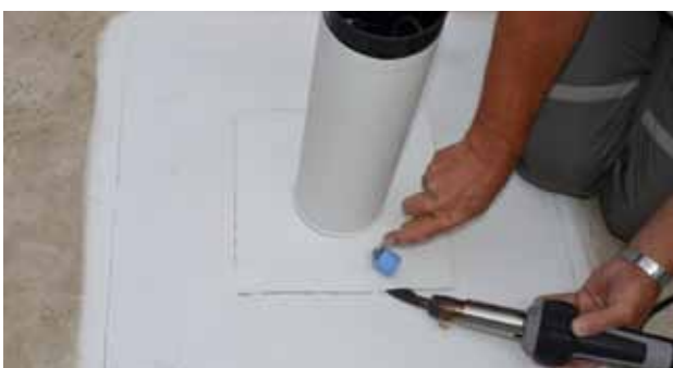
Abdichtung des RCS-Rohrs mit RCS-Einfassung und anschließend Durchführung einer Nahtkontrolle
