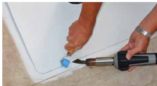
Flächentableau herstellen und aufschweißen
