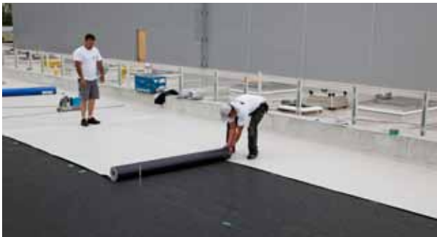
Über dem elektrisch leitfähigen Spezialglasvlies wird die Sarnafil® Abdichtungsbahn verlegt
