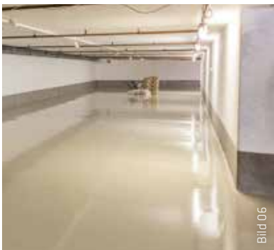
Als händisch verarbeitbare Dichtungsschicht dient Sikafloor®-350 N Elastic.
