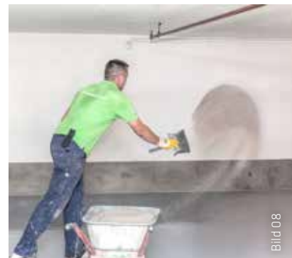
SikaCor® Elastomastic TF wird abgestreut.
