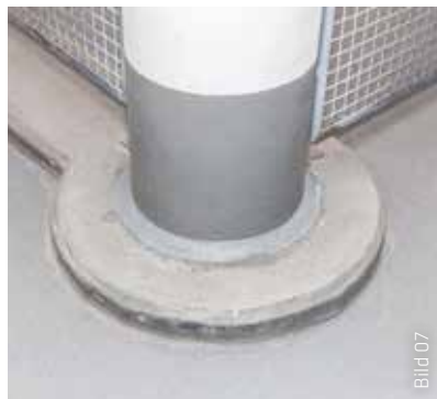
Sikaflex® PRO-3 dichtet Boden- und Wandanschlüsse ab.
