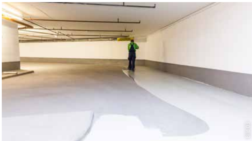
Optimaler Schutz nach OS 8 mit der Grundierung Sikafloor®-161 und der Versiegelung Sikafloor®-378.
