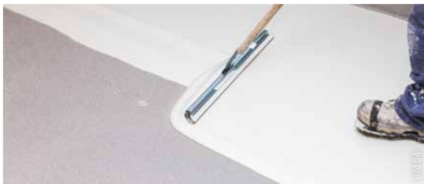
Die Versiegelung Sikafloor®-378 sorgt für eine moderne Farbgebung.
