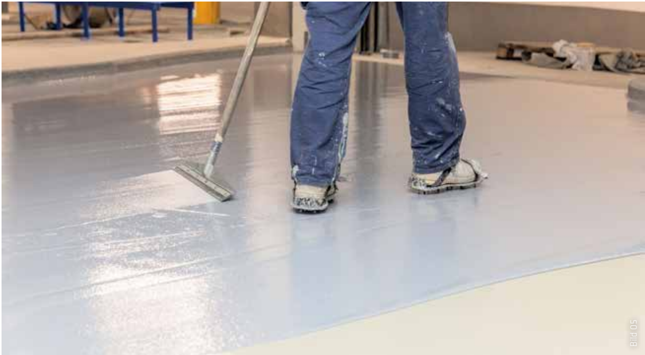
Applikation von SikaCor® Elastomastic TF auf die Dichtungsschicht Sikafloor®-350 N Elastic.
