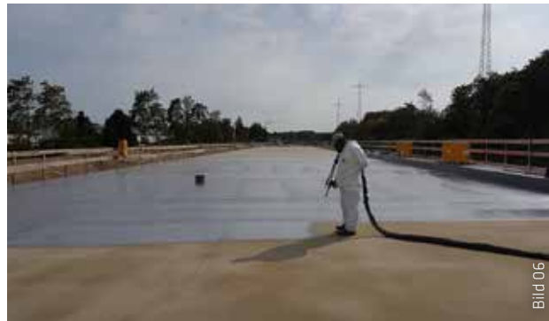
Die zweite, unmittelbar unter dem Aufbeton gelegene Schicht bildete die rissüberbrückende, hochelastische und mechanisch sehr widerstandsfähige Dichtungsschicht Sikalastic®-821 LV. Die 2-komponentige, füllstofffreie Polyurethan-Flüssigkunststoffabdichtung ist schnellhärtend und wurde daher mit einer 2-Komponenten-Heißspritzanlage verarbeitet.
