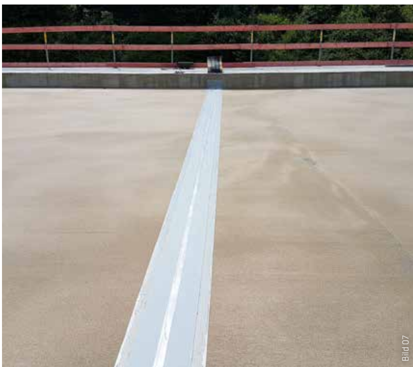
Die Abdichtung der Fugen auf dem Deckel erfolgte nach ZTV-ING Fug 4 mit 2 Millimeter dicken Tricoflex® Dichtstreifen und dem Tricoflex® Systemkleber FU 60. Der Randabschluss am Tunneldeckel erhielt eine Abdichtung mit Tricoflex® DFT 300/3 KF.
