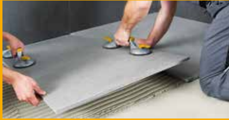
FLIESEN-, WAND- UND FUSSBODENTECHNIK
