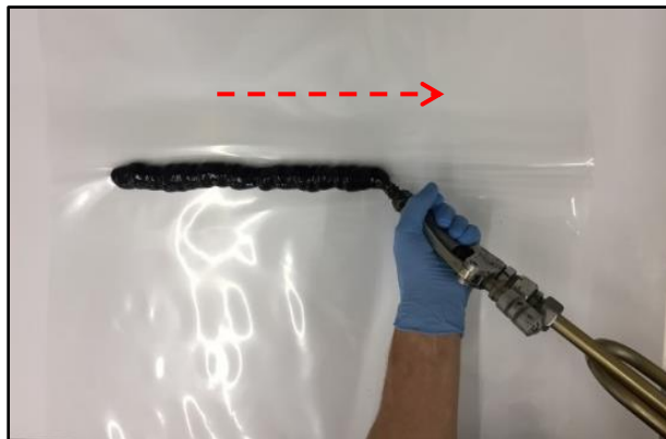
Bild 15: Klebstoffraupe in Richtung des Falzes auftragen
