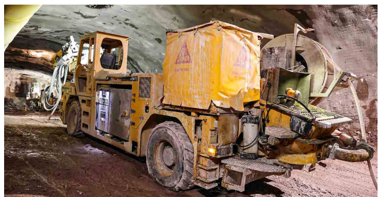
Spritzbetonmobil kurz vor dem Einsatz: Die Wärmeschutzhaube befindet sich auf dem IBC Container, im hinteren Teil ist der Füllbereich für Beton zu sehen.
