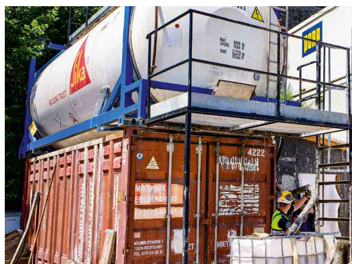
Befüllen des IBC Containers mit dem Spritzbetonbeschleuniger Sika Sigunit L-5401 AF.
