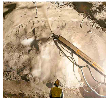
Der Erstarrungsbeschleuniger wird genau dosiert direkt an der Spritzdüse zugeführt.
