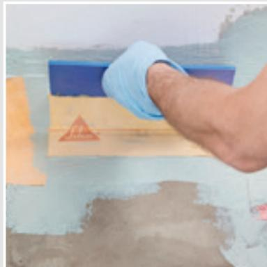
Blasenfreies Einlegen und Andrücken des SCHÖNOX ST FUGEN-DICHTBAND.
