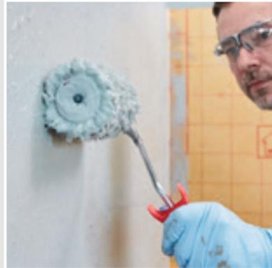
Flächiger SCHÖNOX iFIX® Auftrag mit dem SCHÖNOX iFIX® ROLLER 180 mm.
