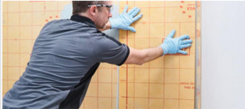
Blasenfreies Einlegen der SCHÖNOX AB in den frischen Dichtkleber mit einer 5 cm Überlappung.
