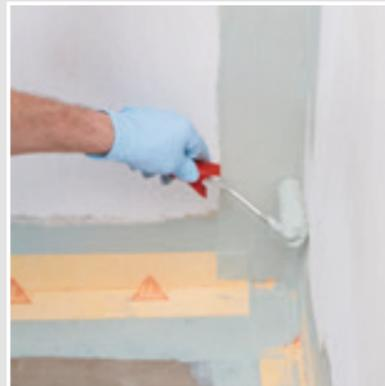
SCHÖNOX iFIX® Auftrag für die Detailverklebungen mit dem SCHÖNOX iFIX® ROLLER 100 mm.
