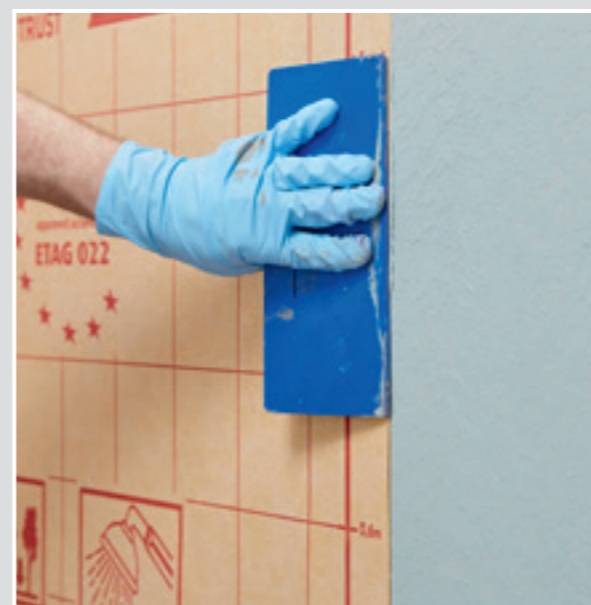
3 Unter Vermeidung von Lufteinschlüssen die Abdichtbahn SCHÖNOX AB 30 andrücken und das überschüssige SCHÖNOX iFIX® herausdrücken.
