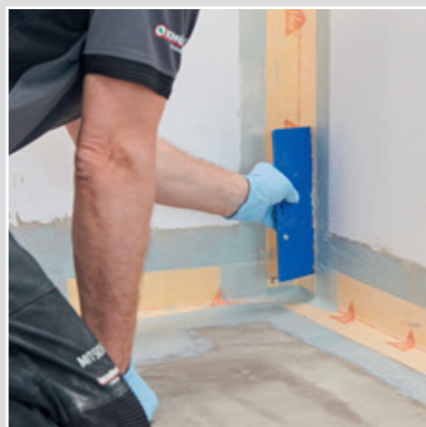
3 Alle Detailabdichtungen unter Vermeidung von Lufteinschlüssen mit dem SCHÖNOX iFIX® TOOL andrücken.
