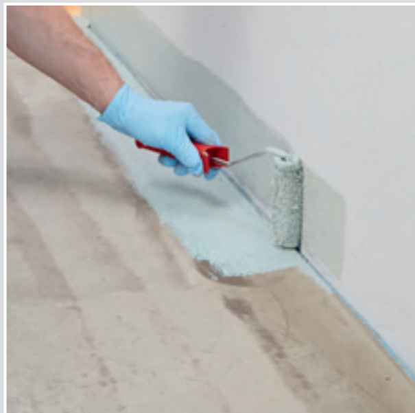
1 In den Ecken und entlang der Wand-Boden/ Wand-Wand-Anschlüsse SCHÖNOX iFIX® mit dem SCHÖNOX iFIX®-ROLLER 100 mm aufrollen.
