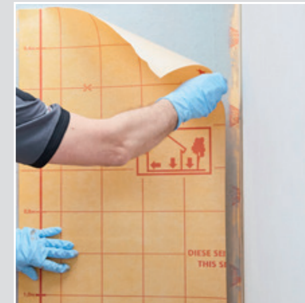
2 Die Dichtbahn SCHÖNOX AB 30 in den frischen Dichtkleber SCHÖNOX iFIX® einlegen. Dabei eine Überlappung von 5 cm einhalten.
