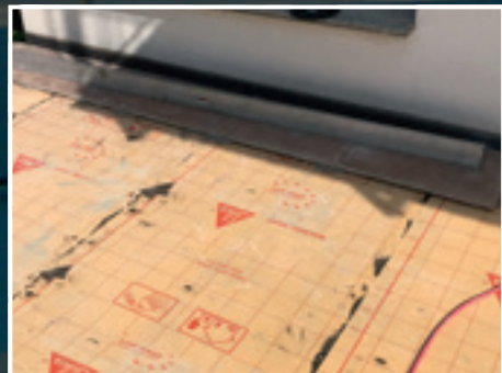
Verklebung von SCHÖNOX AB 30 mit SCHÖNOX iFIX®.
