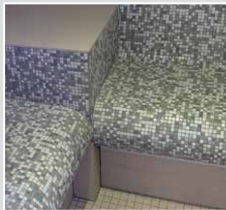
Für eine hohlraumarme Verlegung ist die Buttering-Floating-Methode anzuwenden. Bild links: Der Aufbruch belegt die gute Anhaftung.
