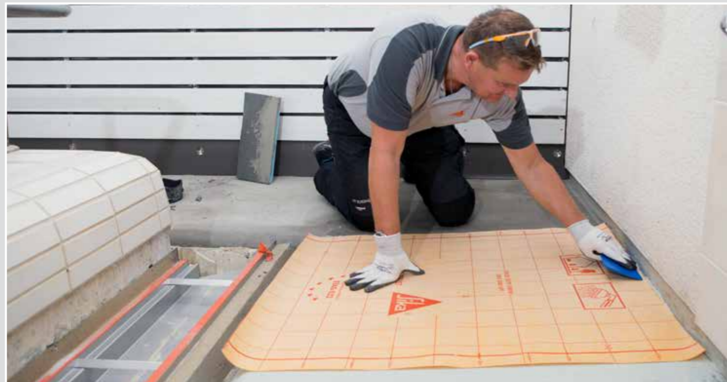
Kleben der SCHÖNOX AB 10/30 mit SCHÖNOX iFIX® mittels SCHÖNOX iFIX® TOOLBOX Werkzeug
