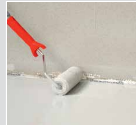
Innerhalb von 12 - 24 Stunden die eingefärbte Lage SCHÖNOX EA PUR mit einer Rolle auftragen.
