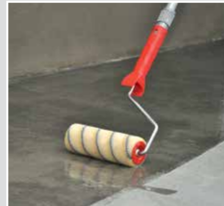
Die Systemgrundierung SCHÖNOX GEA mit einer Kurzflorrolle aufbringen.
