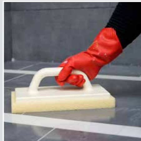
Die Fugen glattwaschen und den Belag mit einem Schwammbrett mit Hydroschwamm oder einem Hydroschwamm reinigen.
