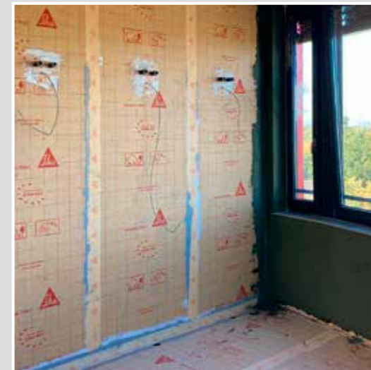
Sonderkonstruktion mit der AIV-B in der Wassereintrittsklasse W3-I. Zügiger Arbeitsablauf gewährleistet zeitnahe Nutzung.
