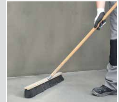
QUARZSAND-Überschuss nach Aushärtung abkehren.
