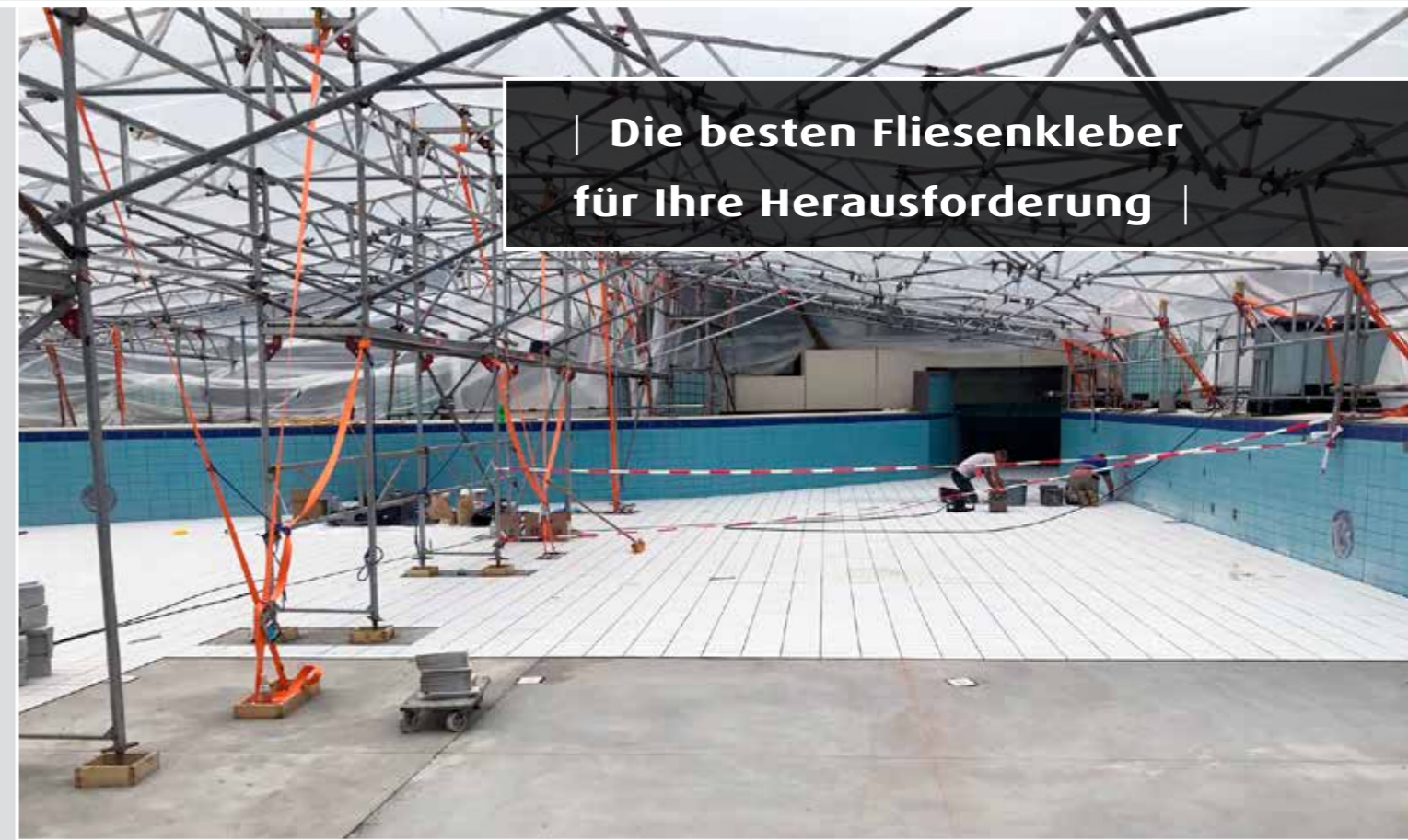
Verlegearbeiten unter einem Witterungsschutz
