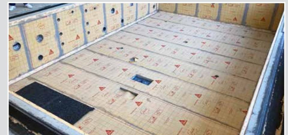
Rechts im Bild: Einsatz der SCHÖNOX AB 10/30 im Unterwasserbereich
