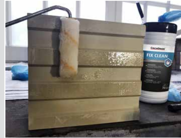
Die Formteiltrückseite wird aus Adhäsionsgründen mit purem SCHÖNOX CON BODEN vorgerollt und nach dem Einsetzen in das Epoxidharzmörtelbett eingeklopft.
