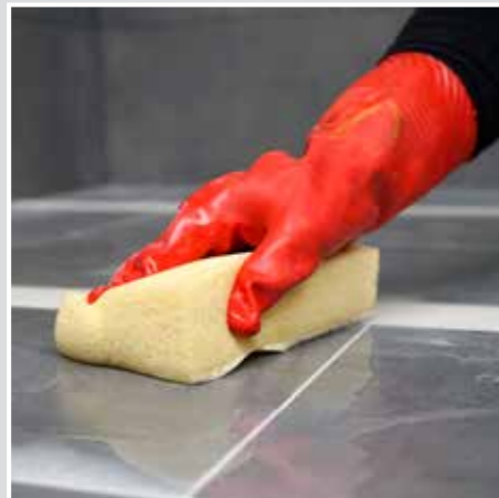
Die Materialreste werden mit einem Hydroschwamm und kaltem Wasser emulgiert.
