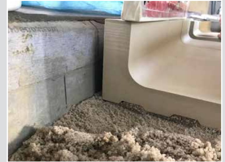
Detailbild des in Epoxidharz-Mörtel eingearbeiteten Formteiles
