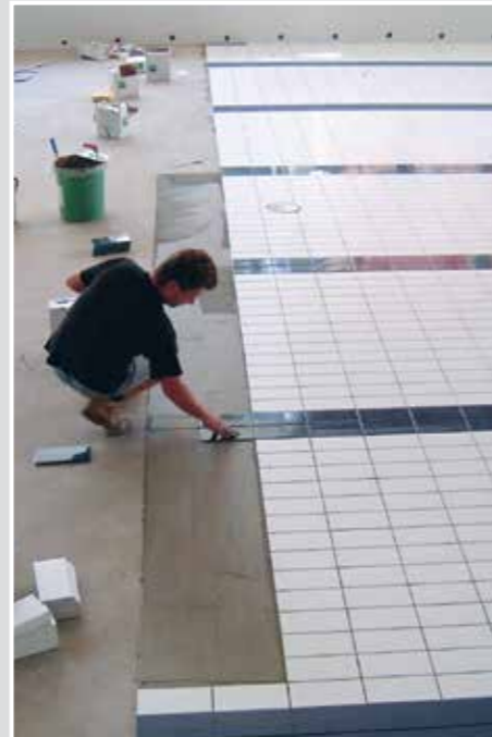
Für eine hohlraumarme Verlegung ist die Buttering-Floating-Methode anzuwenden. Bild links: Der Aufbruch belegt die gute Anhaftung.
