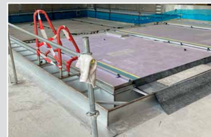
Einblick in die Übergangssituation Edelstahlbecken
