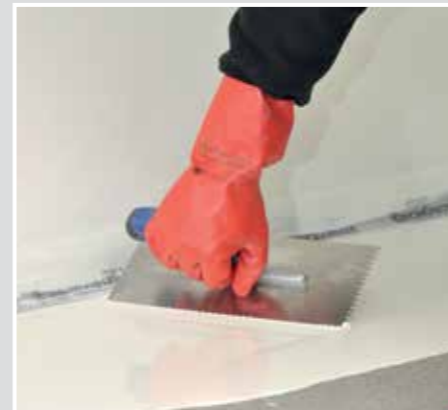
Die Polyurethan-Abdichtung SCHÖNOX EA PUR / EA PUR S mit einer 6er Zahnung aufbringen.
