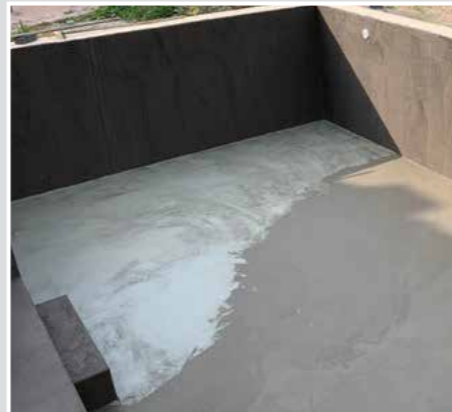
Erstellung einer zementären Verbundabdichtung
