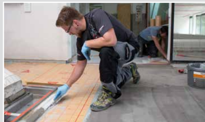
Anpressen von SCHÖNOX AB 10/30 im Bereich der gephasen Vergusskante
