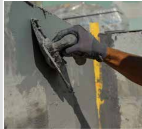
Auftrag der Verbundabdichtung SCHÖNOX 1K DS PREMIUM
