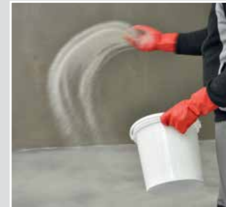
Die grundierte Fläche mit feuertrocknetem QUARZSAND absanden.
