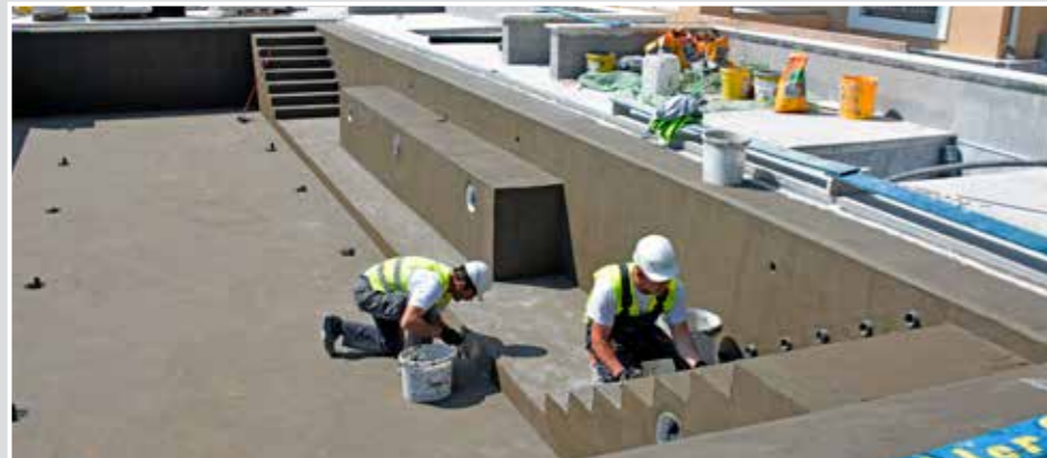
Verarbeitung von SCHÖNOX 1K DS PREMIUM auf mattfeuchtem Betonuntergrund
