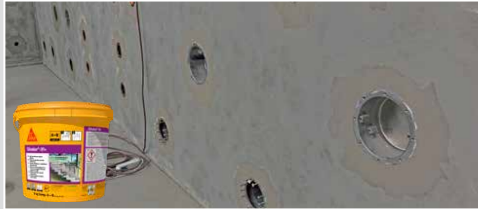
Einbaubeispiel bei unzureichender Flanschauflagefläche
