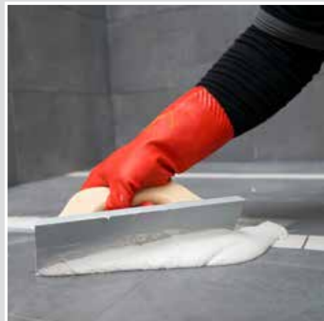
Einarbeiten des Epoxidharz-Fugmaterials SCHÖNOX CF DESIGN.
