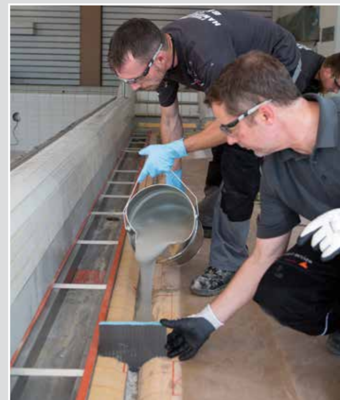
Abschnittsweises Vergießen der kapillarbrechenden Fuge mittels angefertigter Schablone
