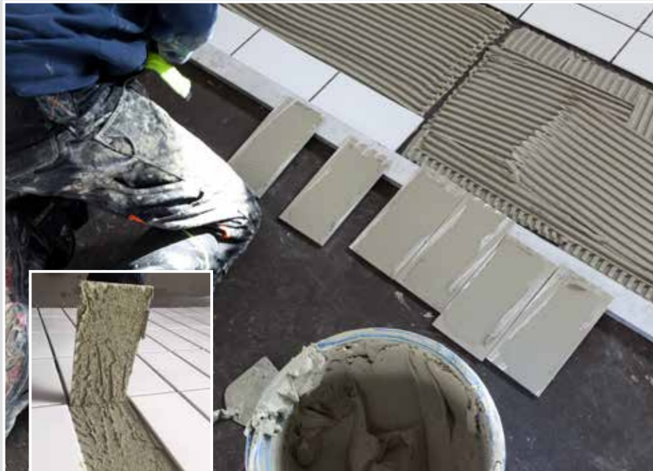
Für eine hohlraumarme Verlegung ist die Buttering-Floating-Methode anzuwenden. Bild links: Der Aufbruch belegt die gute Anhaftung.
