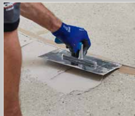
Das Anrampen nicht höhengleicher Flächen ist problemlos möglich.
