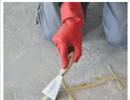
Überstehendes Material sofort mit dem Spachtel verteilen
