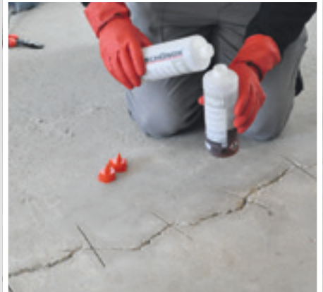
Komp. B in Komp. A gießen; verschließen und mind. 15 Sek. schütteln
