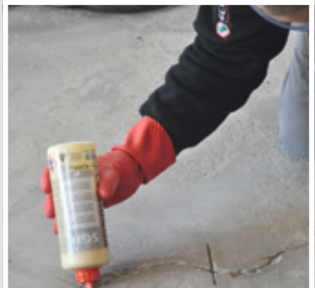
Flaschentülle in Rissbreite abschneiden und Mischung einfüllen
