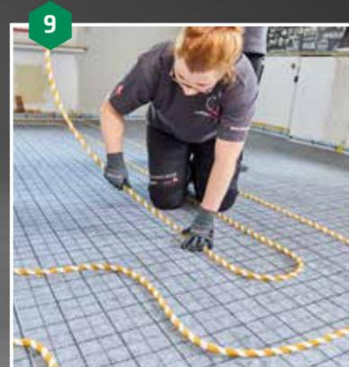
Auf dem Hinweg wird das Heizrohr in einem Verlegeabstand von 30 cm verlegt. Hier kann man sich an den durchgezogenen Linien auf dem Fleece orientieren.
