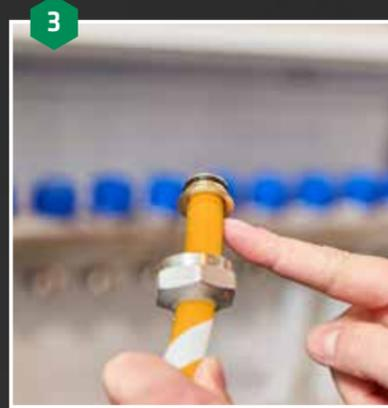
Unbedingt darauf achten, dass das Ventil der Klemmringverschraubung richtig reingedrückt ist.
