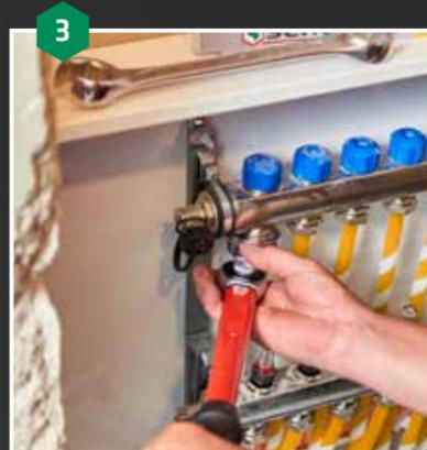
3 Mit dem Drehmomentschlüssel auf 15 Nm festziehen.
