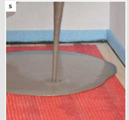
Anschließend wird SCHÖNOX SPF (Schichtdicke 8 - 20 mm) mittels herkömmlicher Methode oder mit Pumptechnik eingebracht.
