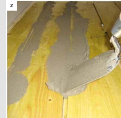
Die Fugen, Risse und Löcher sind mit dem Universalreparaturmörtel SCHÖNOX PL oder SCHÖNOX PL PLUS zu verschließen.
