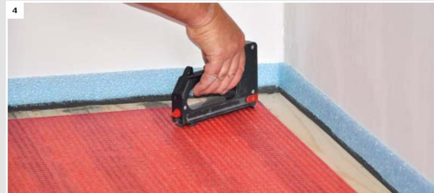
SCHÖNOX PZG auf die gewünschte Größe zuschneiden und mit Überlappungen von 5 cm auf dem Untergrund durch antackern befestigen. An aufgehenden Bauteilen ist ein Abstand von ca. 3 cm einzuhalten.
