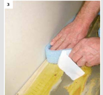
An aufgehenden Bauteilen ist ein SCHÖNOX NIVELLIERRANDSTREIFEN aufzustellen und verbleibende Fugen sind mit Acryl zu schließen.
