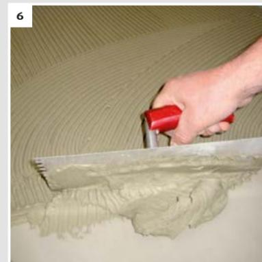
Die weitgehend hohlraumfreie Verlegung des Oberbelags erfolgt mit dem Spezial-Pulverkleber SCHÖNOX Q12.
