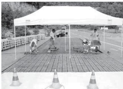
Darüber hinaus stehen auch vorgefertigte Kassetten mit Skid Tiles im Verbund zur Verfügung. Die Verlegung und Verfugung kann mit geprüften Produkten, z.B. SIKA vorgenommen werden.
