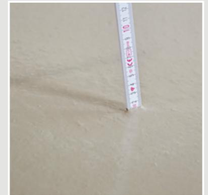
**11** Extrem dünnschichtige Estrichlösung: 14 mm ohne Trittschalldämmung.
