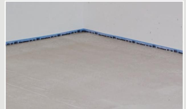
**13** Nach 48 Stunden ist die Fläche verlegereif für nahezu alle Beläge.
