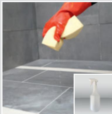
Zum Vornässen den Hydroschwamm oder die in der SCHÖNOX EPOXY TOOLBOX enthaltene Sprühflasche nutzen.
