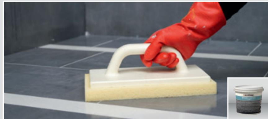
Die Fugen glattwaschen und den Belag mit einem Schwambrett mit Hydroschwamm oder einem Hydroschwamm reinigen. Bei hartnäckigen Harzresten kann SCHÖNOX EPOXY CLEAN als Waschhilfe zur Anwendung kommen.
