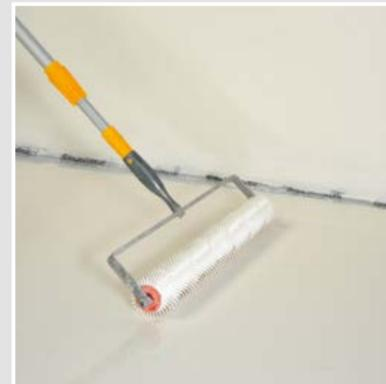
Die Abdichtung mit einer Stachelwalze (Stachellänge ca. 1 cm) abrollen und die Schichtstärke prüfen.
