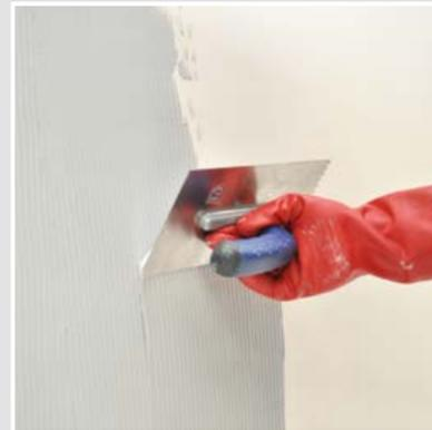
Innerhalb von 12 - 24 Std. die eingefärbte 2. Lage SCHÖNOX EA PUR S mit einer 4er Zahnung auftragen.
