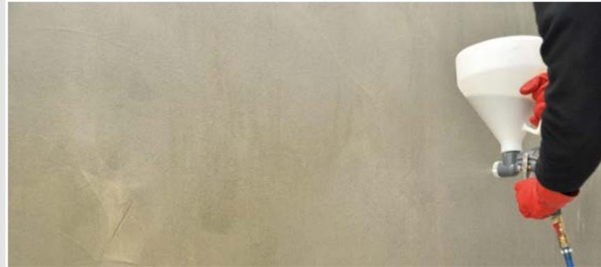
Die grundierte Fläche mittels Trichterpistole mit feuergetrocknetem Quarzsand (0,2 - 0,8 mm) absanden.
