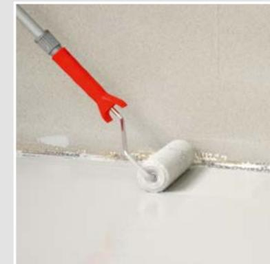
Innerhalb von 12 - 24 Std. die eingefärbte 2. Lage SCHÖNOX EA PUR mit einer Rolle auftragen.
