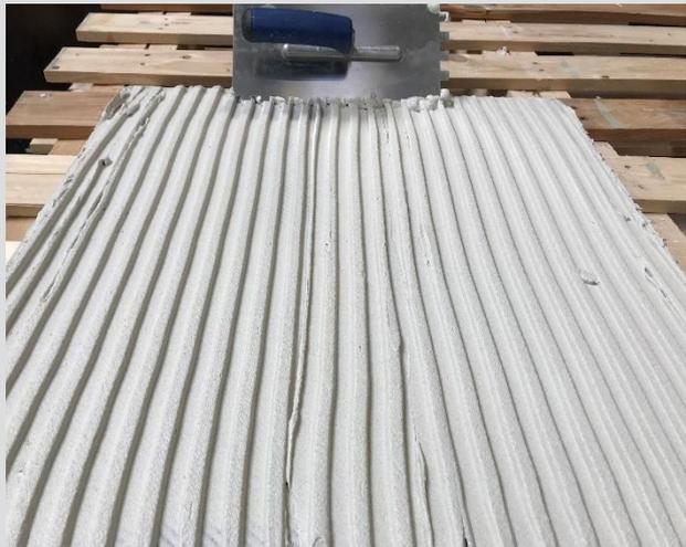
Rückseitiges Aufzählen z. B. von SCHÖNOX Q6 W auf der Fliesenrückseite (sog. Floating-Verfahren)
