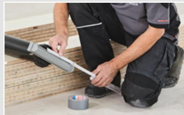
Die Düsenbreite an die Dielenbreite anpassen, ausmessen, passend abkleben, los geht's.
