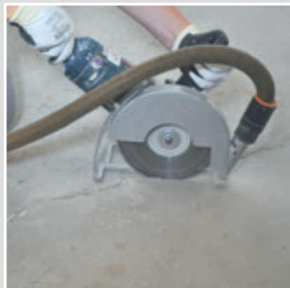
3 Zuerst den Riss aufweiten.
