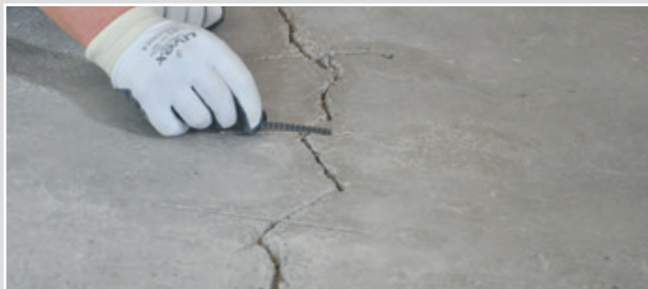
7 Wellenverbinder in die Querfugen einlegen.
