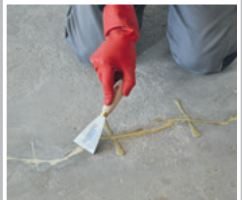
Überstehendes Material sofort mit dem Spachtel verteilen
