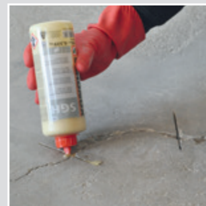
4 Die Estrichrisse mit SCHÖNOX SGH verfüllen.
