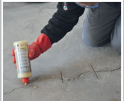
Flaschentülle in Rissbreite abschneiden und Mischung einfüllen
