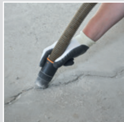
6 Staub und lose Estrichreste absaugen.
