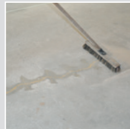
7 ... und nach der Trockenphase abfegen.
