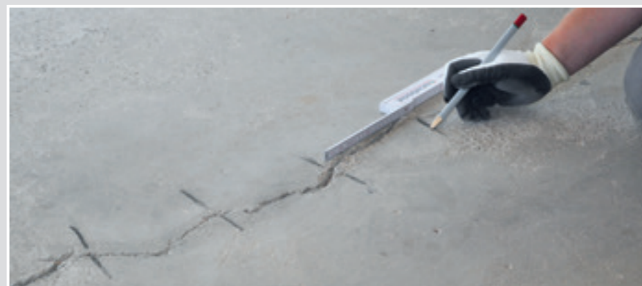
4 Ungefähr alle 20-50 cm eine Querfuge positionieren ...
