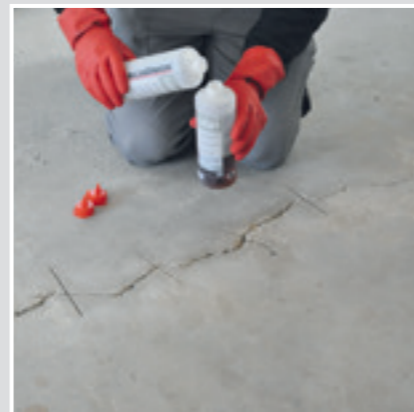
1 SCHÖNOX SGH Komponente B in die Flasche zu SCHÖNOX SGH Komponente A gießen.
