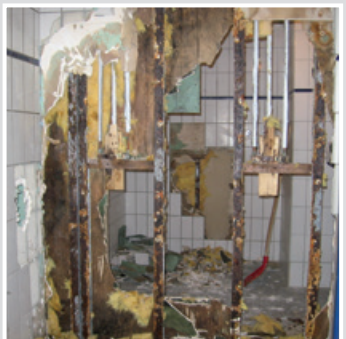
Typische Schäden bei nicht sauber ausgeführten Abdichtarbeiten
