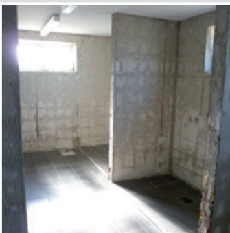
Typische Schäden bei nicht sauber ausgeführten Abdichtarbeiten
