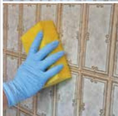
Alte keramische Beläge und Naturwerksteinbeläge müssen fest liegen, sind grundzureinigen und ggf. anzuschleifen.
