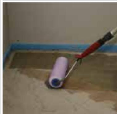
Der Untergrund verfügt über ausreichende Festigkeit, Tragfähigkeit, Formstabilität und Dauertrockenheit und ist frei von haftmindernden Schichten wie z. B. Staub, Schmutz, Öl, Fett und losen Teilen. Je nach Untergrundbeschaffenheit erfolgt eine vorherige Grundierung mit **SCHÖNOX KH FIX**.
