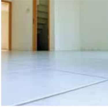
Den Untergrund auf ausreichende Festig- und Tragfähigkeit prüfen. Danach den Altbelag grundreinigen und mechanisch anschleifen. Der Belag muss frei von haftungsmindernden Schichten und sonstigen losen Teilen sein.
