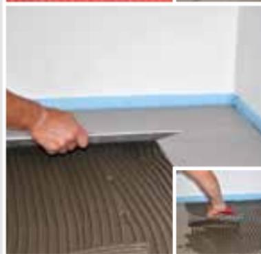
Die Verlegung des keramischen Oberbelags oder verfärbungsunempfindlichen Naturwerkstein erfolgt weitestgehend hohlraumfrei mit dem höchst flexiblen und spannungsabbauenden Spezial-Pulverkleber **SCHÖNOX Q12**.
