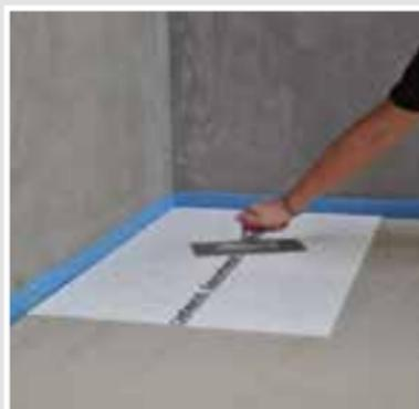
**SCHÖNOX EDP 9 mm** wird im Halbverband, quer zu Fugen im Untergrund verlegt. Dabei ist zu allen aufgehenden Bauteilen wie Wänden und Stützen ein Randabstand von mindestens 5 mm einzuhalten. Die Platten werden stumpf gestoßen, dabei ist zu beachten, dass der Rollkleber nicht durch die Stoßfugen aufsteigt. Die Stöße werden mit handelsüblichem Kreppband überklebt.
