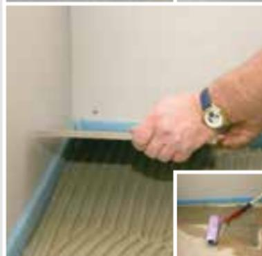
Vor dem Aufziehen des Leicht-Spezialklebers **SCHÖNOX Q8** wird die Fläche mit **SCHÖNOX KH FIX** zur Haftvermittlung grundiert. Der sehr verbrauchs- und verarbeitungsoptimierte Kleber **SCHÖNOX Q8** ist ideal für wirtschaftliches Arbeiten. Verfugt wird mit **SCHÖNOX SU** oder **SCHÖNOX UF PREMIUM**. Das Schließen und Versiegeln von Anschluss- und Bewegungsfugen erfolgt mit **SCHÖNOX ES**.
