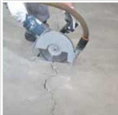
Spannungen im Estrich führen oftmals zu Rissbildungen. Gründe dafür liegen entweder in der zu schnellen Trocknung des noch jungen Estrichs oder aber es liegen thermische, bzw. mechanische Belastungen vor. Estrichrisse sind wie folgt kraftschlüssig zu schließen: Riss aufweiten und alle 20 cm mit einem Winkelschleifer quer einschneiden.
