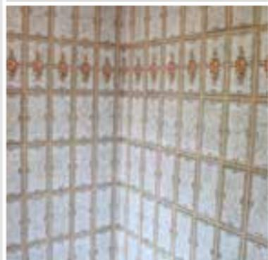
Altbeläge müssen einen ausreichenden Verbund zum Untergrund aufweisen. Verbundschwache Beläge sind zu entfernen.
