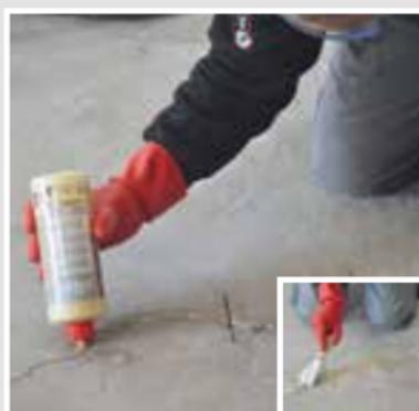
Zum Verfüllen die zweikomponentige Reparaturmasse **SCHÖNOX SGH** in die Risse einbringen und überstehendes Material sofort mit dem Spachtel verteilen. Die Verarbeitungszeit beträgt ca. 10 Minuten.
