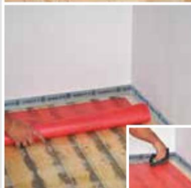
**SCHÖNOX PZG** wird auf dem Untergrund ausgelegt und durch antackern befestigt. **SCHÖNOX PZG** unbedingt 5 cm überlappen lassen und an aufgehenden Bauteilen einen Abstand von ca. 3 cm einhalten. An aufgehenden Bauteilen ist ein **Nivellier-
