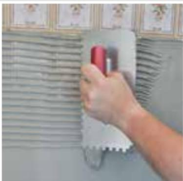
Den Fliesenkleber **SCHÖNOX Q12** mit einem geeigneten Zahnglätter aufziehen und abkämmen. Das Verlegegut in das frische Kleberbett einschieben und eindrücken, bevor die Hautbildung einsetzt. Mörtelreste entfernen.
