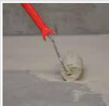
**SCHÖNOX EDP** wird mit dem einkomponentigen **Rollkleber SCHÖNOX RK 20** vollflächig verklebt. Die Platten werden stumpf gestoßen, dabei ist zu beachten, dass der Rollkleber nicht durch die Stoßfugen aufsteigt. Die Stöße werden mit handelsüblichem Kreppband überklebt.
