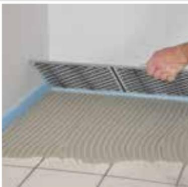
Jetzt kommt der hoch höchst flexible Spezial-Pulerkleber mit sehr guten Verarbeitungseigenschaften **SCHÖNOX Q12** zum Einsatz. Den Fliesenkleber mit einem geeigneten Zahnglätter aufziehen und abkämmen. Das Verlegegut in das frische Kleberbett einschieben und eindrücken, bevor die Hautbildung einsetzt.
