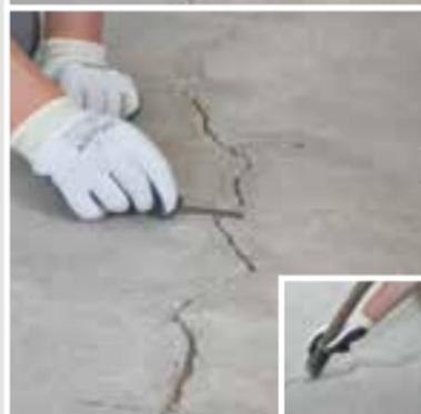
Anschließend Risse und Fugen sorgfältig aussaugen. Jetzt in die Querschlitz die beigepackten Wellenverbinder einlegen.
