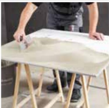
Bei großformatigen Feinsteinzeugfliesen kann es erforderlich sein, eine Kontaktschicht auf der Rückseite mit **SCHÖNOX Q12** aufzubringen.
