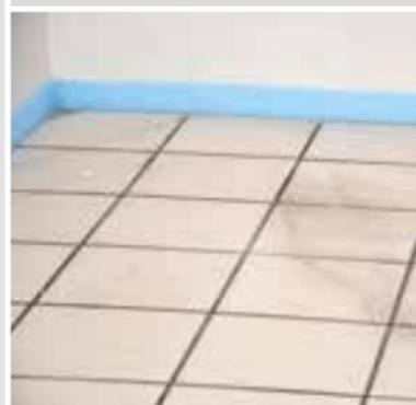
An aufgehenden Bauteilen ist ein **SCHÖNOX NIVELLIERRANDSTREIFEN** aufzustellen, um Schallbrücken und Spannungen zu verhindern. Eventuell verbleibende Fugen sind mit Acryl zu schließen.
