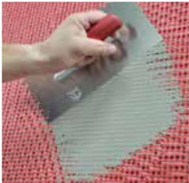
Anschließend wird **SCHÖNOX PZG** vollflächig frisch in frisch mit Fliesenkleber abgespachtelt.
