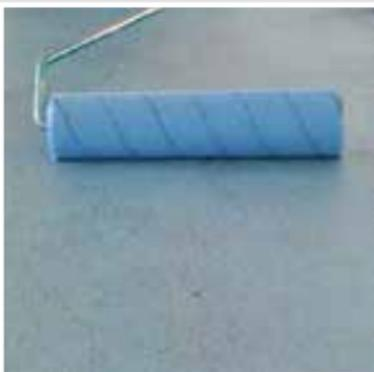
Als haftungsvermittelnder Kunstharzfilm wird die Acrylatspezialdispersion **SCHÖNOX SHP** aufgetragen. **SCHÖNOX SHP** vor Gebrauch aufrühren und mit einer Kurzflorrolle oder einem Flächenstreicher gleichmäßig auf den trockenen Untergrund auftragen.
