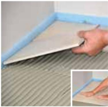
Den Verlegemörtel mit einem geeigneten Zahnglätter aufziehen und abkämmen. Das Verlegegut in das frische Kleberbett einschieben und eindrücken, bevor die Hautbildung einsetzt. Mörtelreste von den Fliesen entfernen. Die Verlegung des Oberbelages muss weitestgehend hohlraumfrei erfolgen.
