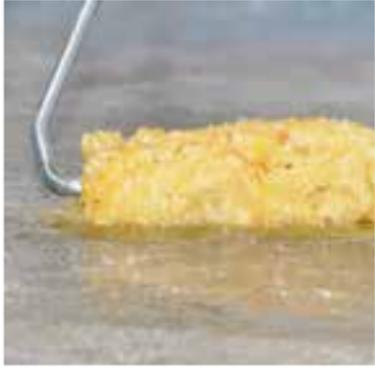
Es muss sichergestellt sein, dass der Estrich dauertrocken ist und auch bleibt. Der Schutz vor Feuchte – auch aus dem Fliesenkleber – muss gewährleistet sein. Daher wird die Epoxidharz-Grundierung **SCHÖNOX GEA** eingesetzt.
