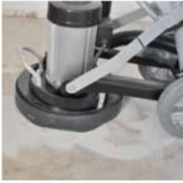
Alte wasserfeste Klebstoffe sind mechanisch weitestgehend zu entfernen. Alte wasserlösliche Klebstoffe, z.B. Sulfid-Ablauge-Kleber sind vollständig zu entfernen.
