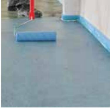
Die Acrylatspezialdispersion **SCHÖNOX SHP** wird auf die ausgehärtete Grundierung **SCHÖNOX GEA** aufgetragen. Das erspart das arbeits- und zeitintensive Abstreuen mit Quarzsand und dem damit verbundenen Entfernen des Überschusses.
