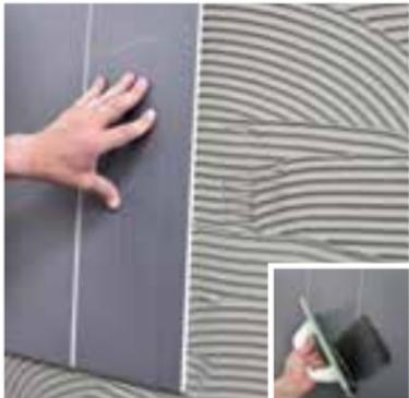
Der keramische Oberbelag wird mit **SCHÖNOX Q12** verklebt. **SCHÖNOX Q12** wirkt entkoppelnd, baut Spannungen ab und ist in vielen Anwendungsbereichen ohne Grundierung einsetzbar. Die Verfugung wird in der Regel mit den Universal-Flexfugen **SCHÖNOX SU** oder **SCHÖNOX UF PREMIUM** ausgeführt. Belagsspezifische Besonderheiten sind zu berücksichtigen.
