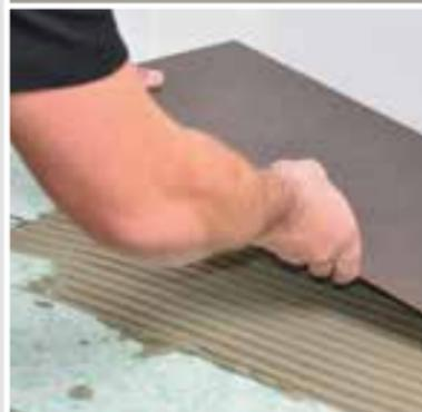
Die Verlegung mit dem stark staubreduzierten Leicht-Spezialkleber **SCHÖNOX Q8** muss weitgehend hohlraumfrei erfolgen. Verfugt wird mit **SCHÖNOX SU** oder **SCHÖNOX UF PREMIUM**. Belagsspezifische Besonderheiten sind bei der Verfugung zu berücksichtigen. Das Schließen und Versiegeln von Anschluss- und Bewegungsfugen erfolgt mit **SCHÖNOX ES**.
