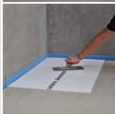
Die Entkopplungsplatte **SCHÖNOX EDP** wird mit **SCHÖNOX RK 20** auf dem sauberen, trag- und haftfähigen Untergrund vollflächig verklebt. Die Platten werden stumpf gestoßen, dabei ist zu beachten, dass der Kleber nicht durch die Stoßfugen aufsteigt. Die Stöße werden mit handelsüblichem Kreppband überklebt.
