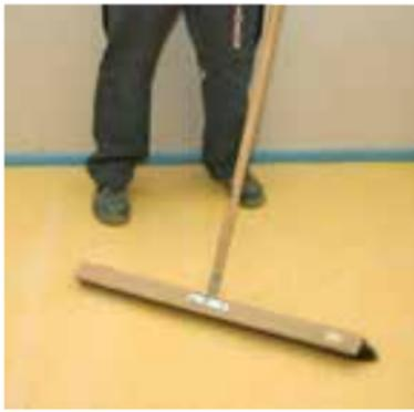
Den Untergrund auf ausreichende Festig- und Tragfähigkeit prüfen. Danach den elastischen Altbelag grundreinigen und mechanisch anschleifen.
