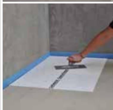
Dabei ist zu allen aufgehenden Bauteilen wie Wänden und Stützen ein Randabstand von mindestens 5 mm einzuhalten. Der Randabstand ist durch einen aufgehenden Randstreifen zu gewährleisten.
