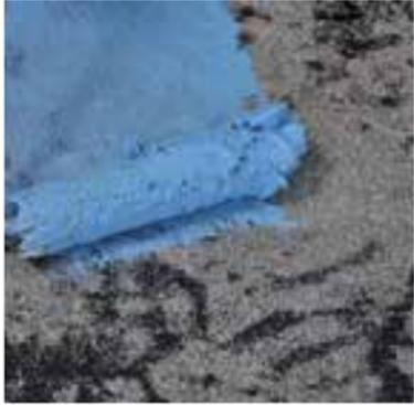
Für keramische Fliesen und Platten müssen Gussasphaltestrichen der Härteklasse IC 10 oder IC 15 entsprechen. Bei bestehenden Gussasphaltestrichen ist ggf. die Härteklassenprüfung in einem Asphaltlabor anzuraten. Unzureichend abgesandete Oberflächen werden mit **SCHÖNOX SHP** grundiert.
