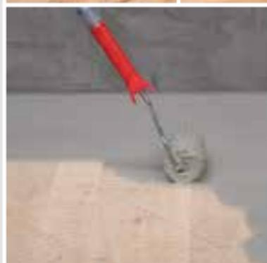
Die Entkopplungs- und Dämmplatte **SCHÖNOX EDP 9 mm** wird mit dem ein-komponentigen Rollkleber **SCHÖNOX RK 20** vollflächig verklebt. Hierzu wird der Rollkleber mit dem **SCHÖNOX iFIX® Rolle 180 mm** satt und gleichmäßig aufgerollt.
