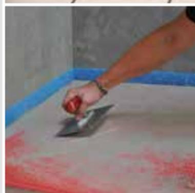
Das Panzergewebe **SCHÖNOX PZG** wird blasen- und faltenfrei in den einkomponentigen Rollkleber **SCHÖNOX RK 20** oder den Fliesenkleber **SCHÖNOX Q12** eingelegt. Anschließend wird **SCHÖNOX PZG** vollflächig frisch in frisch mit dem Kleber abgeglättet. An aufgehenden Bauteilen einen Abstand von min. 3 cm lassen.
