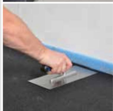
**SCHÖNOX TSD 3 mm** vor der Verlegung im trockenen und temperierten Raum lagern und ca. 24 Stunden akklimatisieren lassen. Die einzelnen Bahnen werden dicht aneinander gestoßen, die Stöße werden mit einem handelsüblichen Kreppband überklebt.
