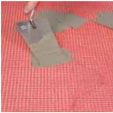
Zur Herstellung eines Haftesverbundes wird mit der schnelltrocknenden Kunstharzhaftdispersion **SCHÖNOX KH FIX** grundiert. Das Panzergewebe **SCHÖNOX PZG** wird flächig ausgelegt. An allen aufgehenden Bauteilen ca. 3 cm Abstand halten. Ein Aufschwimmen von **SCHÖNOX PZG** wird durch punktuelles Fixieren auf dem Untergrund vermieden.
