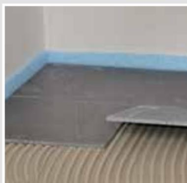
Die Verlegung des keramischen Oberbelags oder verfärbungsunempfindlicher Naturwerksteine erfolgt weitestgehend hohlraumfrei mit dem hochflexiblen und spannungsabbauenden Spezial Pulverkleber **SCHÖNOX Q12**.
