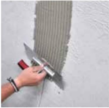
Zur Verklebung ist der höchst flexible und spannungsabbauende Spezial-Pulverkleber **SCHÖNOX Q12** ideal. Überall, wo Untergründe Spannungen ausgesetzt sind, verhindert **SCHÖNOX Q12** durch seine höchst flexible Verformbarkeit effektiv Abschereffekte, Risse oder Brüche.
