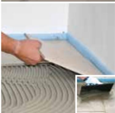
Für die anschließende Fliesenverlegung wird der höchst flexible Spezial-Pulverkleber **SCHÖNOX Q12** eingesetzt. Dieser Fliesenkleber wirkt entkoppelnd, baut Spannungen ab und ist für diese Anwendungsbereiche ohne Grundierung einsetzbar. Verfugt wird mit **SCHÖNOX SU** oder **SCHÖNOX UF PREMIUM**. Das Schließen und Versiegeln von Anschluss- und Bewegungsfugen erfolgt mit **SCHÖNOX ES**.
