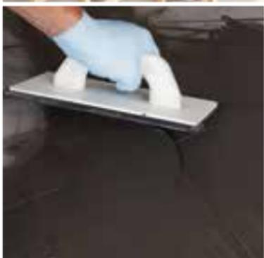
Die Verlegung des Oberbelages muss weitestgehend hohlraumfrei erfolgen. Die Verfugung wird in der Regel mit den Universal-Flexfugen **SCHÖNOX SU** oder **SCHÖNOX UF PREMIUM** ausgeführt. Belagsspezifische Besonderheiten sind bei der Verfugung zu berücksichtigen.
