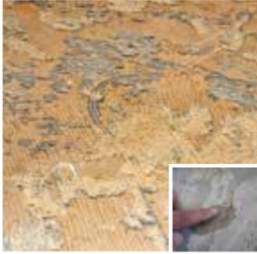
Altbeläge müssen einen ausreichenden Verbund zum Untergrund aufweisen. Alten Belag, wie Teppich, PVC oder Linoleum weitestgehend entfernen.
