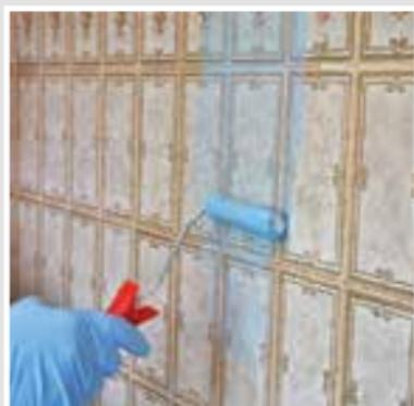
Ein optimaler Haftverbund – insbesondere auf alten keramischen Belägen – wird mit der sehr emissionsarmen, lösemittelfreien, 1-komponentigen Acrylatspezialdispersion **SCHÖNOX SHP** erzielt.
