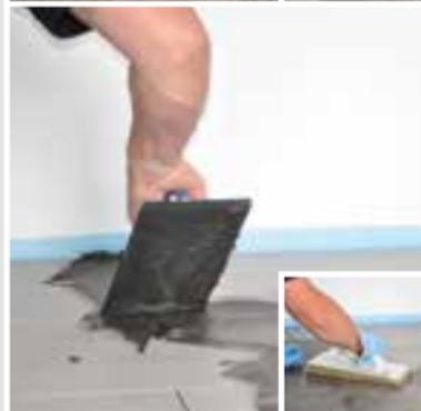
Die Verfugung wird in der Regel mit den Universal-Flexfugen **SCHÖNOX SU** oder **SCHÖNOX UF PREMIUM** ausgeführt. Belagsspezifische Besonderheiten sind bei der Verfugung zu berücksichtigen. Das Schließen und Versiegeln von Anschluss- und Bewegungsfugen erfolgt mit **SCHÖNOX ES**.
