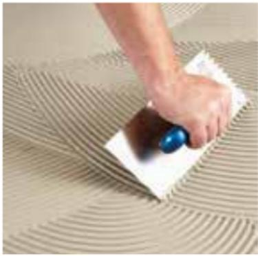
Den stark staubreduzierten, höchst flexiblen Spezial-Pulverkleber **SCHÖNOX Q12** mit einem geeigneten Zahnglätter aufziehen und abkämmen. Das Verlegegut in das frische Kleberbett einlegen und eindrücken, bevor die Hautbildung einsetzt. Mörtelreste entfernen.
