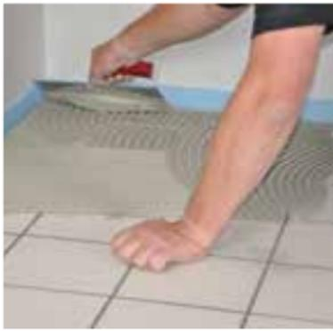
Den Altbelag grundreinigen und bei Bedarf anschleifen. Eine Grundierung ist in diesem Fall nicht erforderlich.
