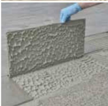
Bei großformatigen Fliesen kann es erforderlich sein, eine Kontaktschicht auf der Rückseite aufzubringen. Für die Verlegung von Großformaten empfehlen wir **SCHÖNOX Q12**. Die Verlegung des Oberbelages muss weitestgehend hohlraumfrei erfolgen.
