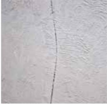
Armierung mit **SCHÖNOX Q12** auf Mischmauerwerk oder Mischuntergründen bei Wandflächen, um Spannungen für nachfolgende Putz- oder Mörtelschichten aufzunehmen.
