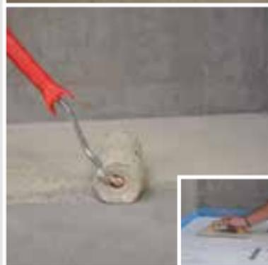
Den einkomponentigen Rollkleber **SCHÖNOX RK 20** mit dem **SCHÖNOX iFIX® ROLLER 180 mm** satt und gleichmäßig aufrollen. Die Entkopplungsbahn **SCHÖNOX EB V** faltenfrei und auf Stoß in das Kleberbett einlegen. Lufteinschlüsse und Hohlräume sind zu vermeiden.
