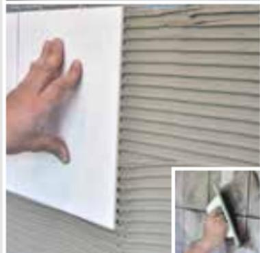
Die Verlegung des Oberbelages muss weitestgehend hohlraumfrei erfolgen. Die Verfugung wird in der Regel mit den Universal-Flexfugen **SCHÖNOX SU** oder **SCHÖNOX UF PREMIUM** ausgeführt. Belagsspezifische Besonderheiten sind bei der Verfugung zu berücksichtigen. Das Schließen und Versiegeln von Anschluss- und Bewegungsfugen erfolgt mit **SCHÖNOX ES**.
