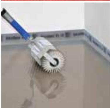
Zur Erzielung ebener Flächen empfehlen wir den Einsatz einer geeigneten Stachelwalze – Stachellänge > 30 mm – wodurch die Spachtelmasse im Verlauf unterstützt und zusätzlich entlüftet wird. Begehbar ist **SCHÖNOX SPF** bereits nach 3 h. Verlege- reife wird bei einer Schichtdicke bis 10 mm nach 24 h für keramische Beläge erreicht.
