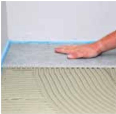
Die Verlegung des Oberbelages muss weitestgehend hohlraumfrei erfolgen. Die Verfugung wird in der Regel mit den Universal-Flexfugen **SCHÖNOX SU** oder **SCHÖNOX UF PREMIUM** ausgeführt. Belagsspezifische Besonderheiten sind bei der Verfugung zu berücksichtigen. Das Schließen und Versiegeln von Anschluss- und Bewegungsfugen erfolgt mit **SCHÖNOX ES**.
