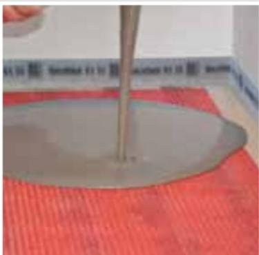
Anschließend erfolgt das vollflächige Spachteln. Die sehr spannungsarme, biege- feste sowie faserverstärkte Nivelliermasse **SCHÖNOX SPF** wird entweder herkömmlich oder mittels Pumptechnik eingebracht.
