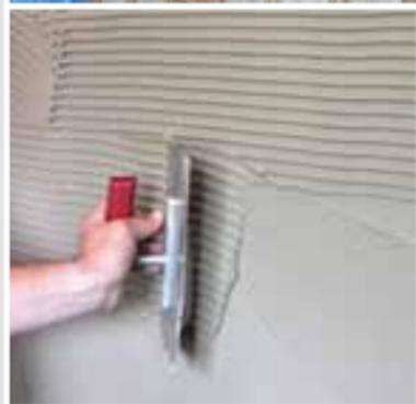
Den stark staubreduzierten Leicht-Spezialkleber **SCHÖNOX Q8** mit einem geeigneten Zahnglätter aufziehen und abkämmen. Das Verlegegut in das frische Kleberbett einschieben und eindrücken, bevor die Hautbildung einsetzt. Mörtelreste von den Fliesen entfernen.
