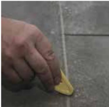
Zum Schließen und Versiegeln von Anschluss- und Bewegungsfugen eignet sich ideal **SCHÖNOX ES**. Fliesenrandbereich mit Selbstklebeband abdecken. Fugen gleichmäßig mit **SCHÖNOX ES** ausspritzen. Oberfläche sofort mit einem mit geeigneten Silikon-Glättmittel benetztem Glättwerkzeug glätten.
