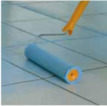
Vor Gebrauch die Spezialgrundierung **SCHÖNOX SHP** aufrühren. Die Grundierung mit einer Kurzflorrolle oder einem Flächenstreicher gleichmäßig auf den trockenen Untergrund auftragen. Pfützenbildung vermeiden.
