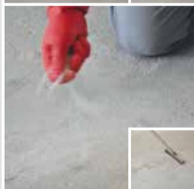
Noch in der Frischphase mit **SCHÖNOX QUARZSAND** (0,2–0,8 mm) im Überschuss abstreuen. Bis zum Aushärten den Riss nicht belasten. Nach ca. 30 Minuten ist der Riss dann kraftschlüssig verschlossen. Die Quarzsandreste müssen abgefegt werden.
