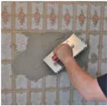
Den Altbelag grundreinigen und bei Bedarf anschleifen. Eine Grundierung ist in diesem Fall nicht erforderlich, sofern eine Kratzspachtelung durchgeführt wird.
