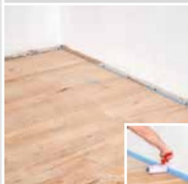
Der Untergrund muss frei von haftmindernden Schichten wie z. B. Staub, Schmutz, Öl, Fett und losen Teilen sein. Unbedingt einen **NIVELLIERRANDSTREIFEN** setzen. Holzuntergründe wie z. B. festliegende Holzdielen mit **SCHÖNOX KH FIX** (Trockenzeit min. 1 Stunde) grundieren.
