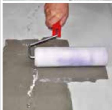
Zur Herstellung eines Haftverbunds wird der Altbelag mit der schnelltrocknenden Kunstharzhaftdispersion **SCHÖNOX KH FIX** grundiert.
