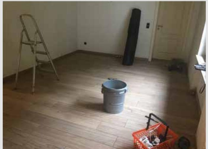
**Blick kurz vor der Endreinigung auf die mit SCHÖNOX Q9 verlegte und mit SCHÖNOX SF Design verfugte Fläche. Mindestens sieben Tage nach dem Verfugen des Belages erfolgt das Aufheizen nach Vorgabe der Firma Schlüter-Systems, Iserlohn.**
