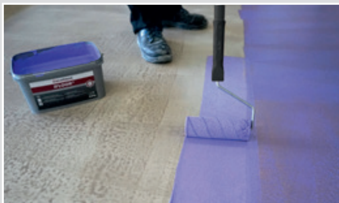
Die intensive Farbstellung erleichtert die Kontrolle des Materialauftrags.
