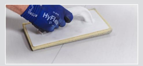
Beim Entfernen des Überschussmaterials werden aufgrund des geringen Wasseranteils die Konturen der Fugen gleich mitgeformt und ein hoher Füllgrad wird erreicht.
