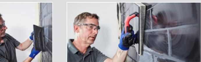
Wenn die Fuge eingebracht ist, den Zeitpunkt des Waschens über den Fingerdrucktest ermitteln. Erst wenn der Fugenmörtel in der Fugen ausreichend angezogen hat, wird der Belag abgewaschen.
