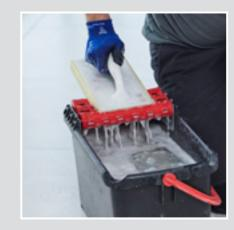
Der Einsatz einer Waschbox erleichtert die Reinigung des Schwammbretts und damit das Reinigen der Fläche.
