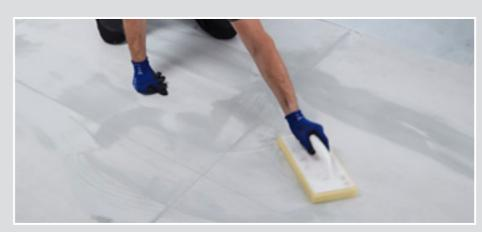
Um das angezogene Material einfach von der Fliesenoberfläche zu entfernen, ohne die Fuge bereits zu tief auszuwaschen, ist der Belag mit wenig Wasser zu befeuchten. Dieses kann ggf. auch sehr gut mit einer Sprühflasche erfolgen. Anschließend das Wasser einwirken lassen.
