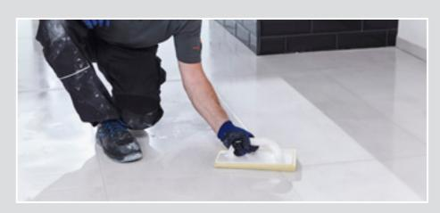
Falls nach dem Waschen noch leichte Fugenschleier vorhanden sind, werden diese mit wenig, aber sauberem Wasser, einem Schwammbrett oder auch einem Mikrofasertuch entfernt. So wird Wasser im Überschuss auf den Fugen vermieden.
