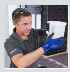
Die passende Wassermenge ablitern. Das 5,0 kg Gebinde mit ca. 1,4 l - 1,45 l Wasser anrühren.
