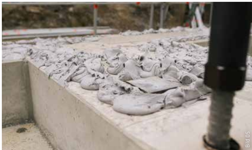
Sikadur®-31 CFN eignet sich zur Verklebung von Betonfertigteilen unterschiedlicher Rauigkeiten.
