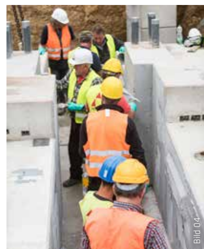
Das Auftragen des 2-K-Epoxidharzmörtels Sikadur®-31 CFN und das Positionieren der Fertigteile musste jeweils in weniger als einer Stunde passieren.
