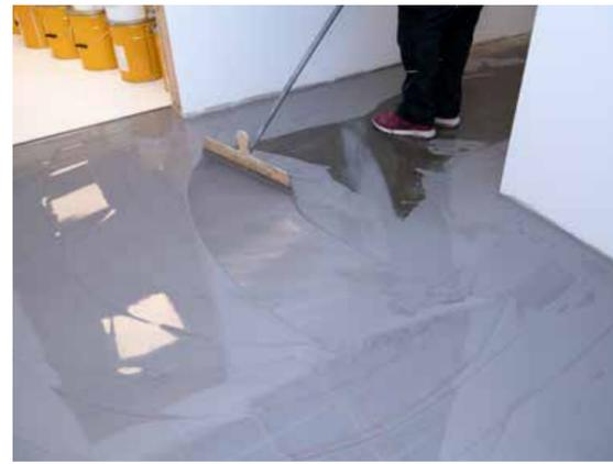
Für die Beschichtung verwendeten die Techniker Sikafloor®-3000 FX, eine elastische, glatte PU-Verlaufsbeschichtung mit ästhetischem Marmoreffekt aus der Sika ComfortFloor® Marble FX Reihe.
