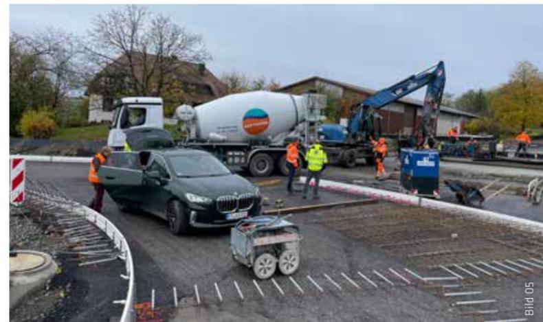
Der angelieferte F3 Beton wird mit einem Bagger und händisch eingebaut.
