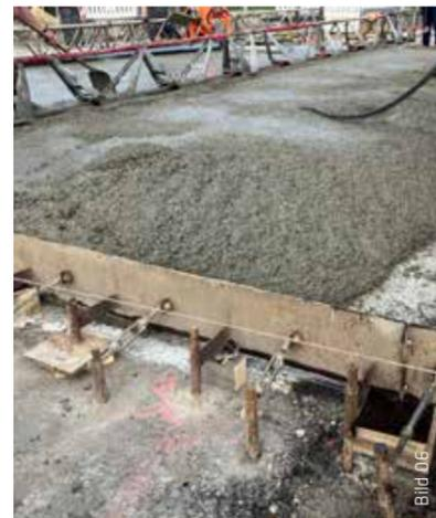
Der Beton wurde mit einer Rüttelflasche verdichtet.
