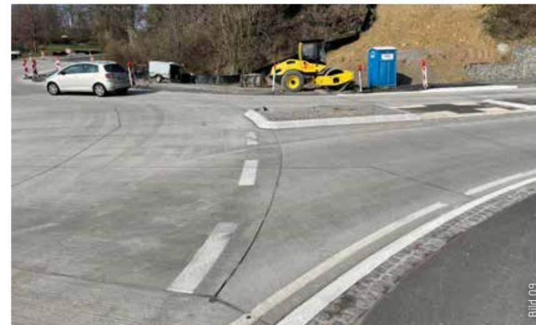
Die Fugen wurden am Tag nach dem Einbau geschnitten.
