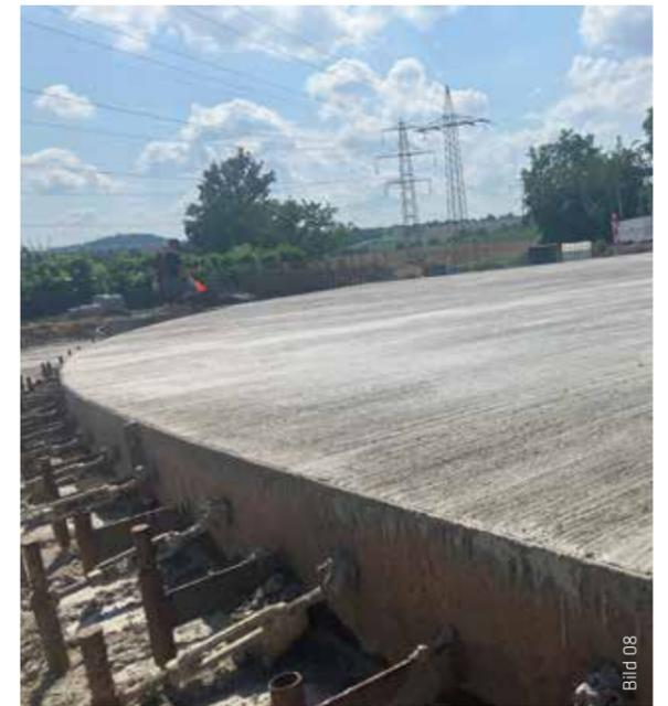
Die fertige Oberfläche wurde mit einem Besenstrich versehen und anschließend ein Nachbehandlungsmittel aufgesprüht.
