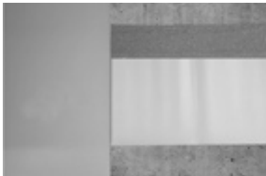
Lineare Befestigung an das Sika® Dilatec® Band
