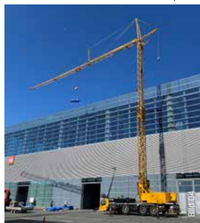
Die Sarnafil®-Dachabdichtungsbahnen wurden mit einem Mobilkran auf das Dach gebracht.
