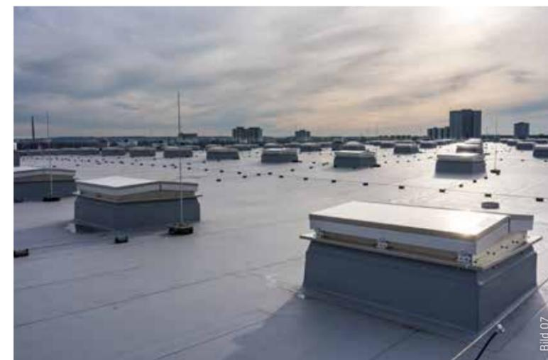
Bei den vorhandenen RWA und Lüftern wurde die Dachbahn am oberen Abschluss mit einem Verbundblech befestigt, die Abdichtung an der Aufkantung hochgeführt und mit dem Verbundblech thermisch verschweißt.
