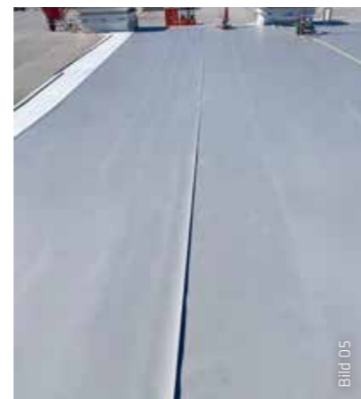
Die Kunststoffabdichtungsbahn Sarnafil® AT-18 wurde lose verlegt, mechanisch befestigt und mit dem Automaten verschweißt.
