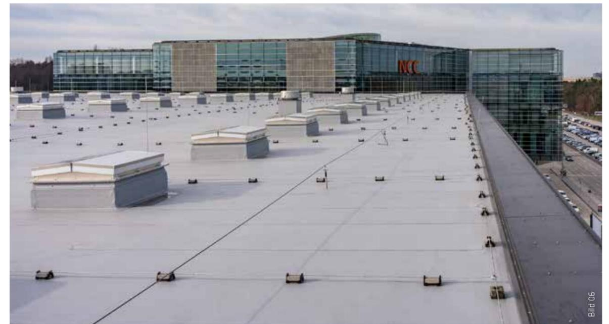
Auf dem 7.500 qm großen Dach der Halle 4A befinden sich insgesamt 98 Rauch- und Wärmeabzugsanlagen (RWA) und acht Lüfter.
