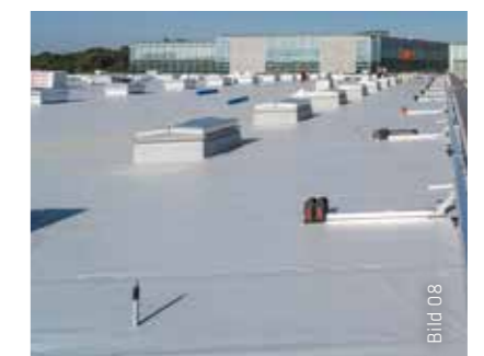
Die Sekuranten-Sicherung wurde ab- und wieder anmontiert, um die Stützen mit Sarnafil® einfassen zu können.
