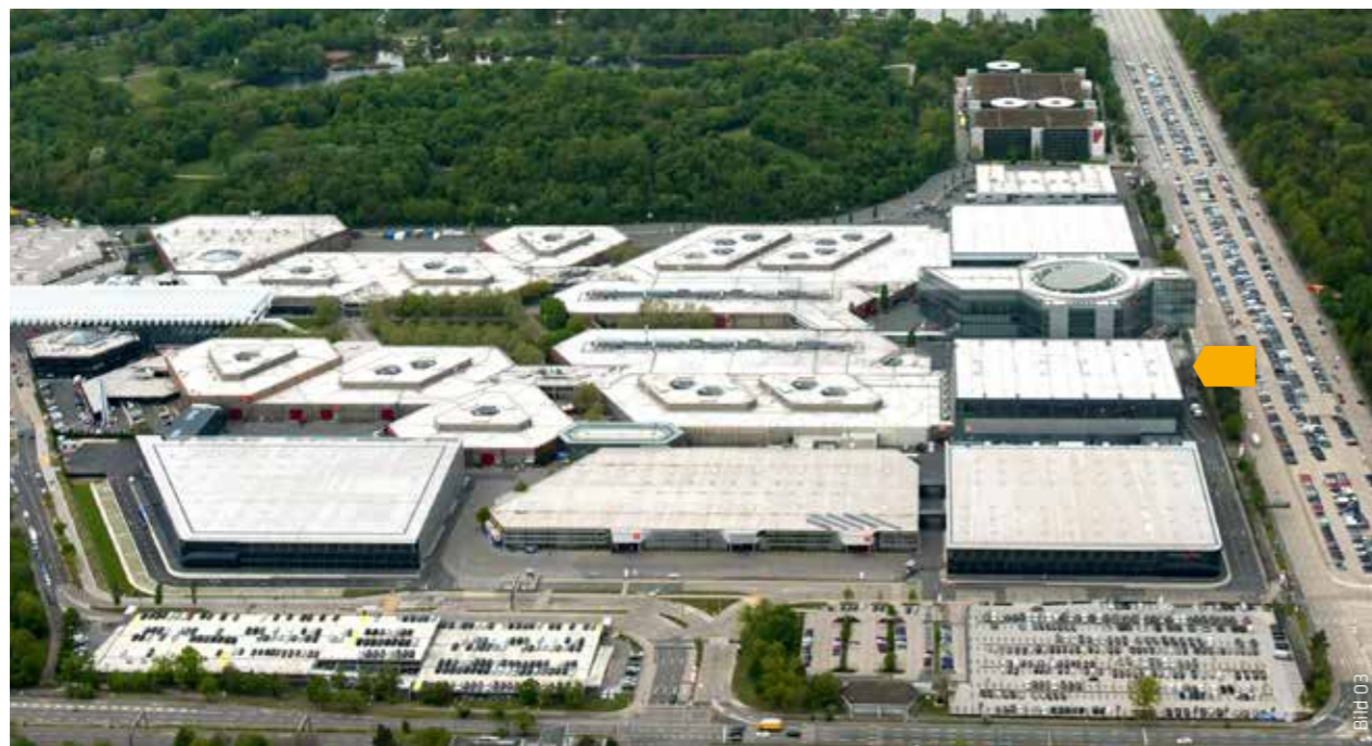
Die Hallendächer der NürnbergMesse werden mit einer neuen Dachabdichtung und PV-Anlagen versehen. Begonnen wurde mit Halle 4A (Pfeil).
