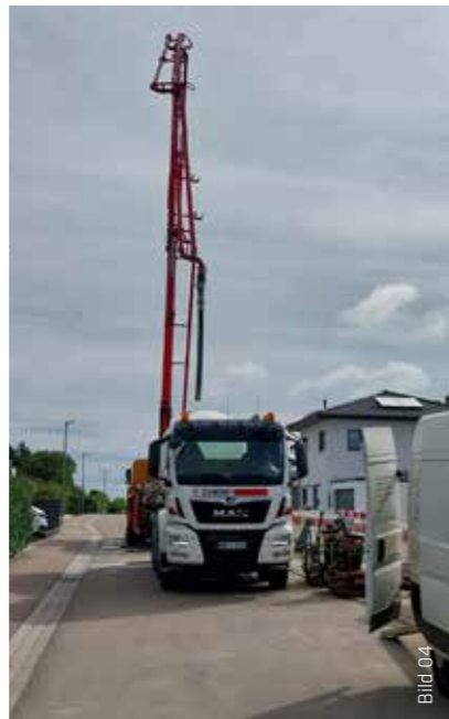
Mit dem Polymerfaserbeton liefert das Transportbetonwerk einen Beton inklusive Bewehrung.
