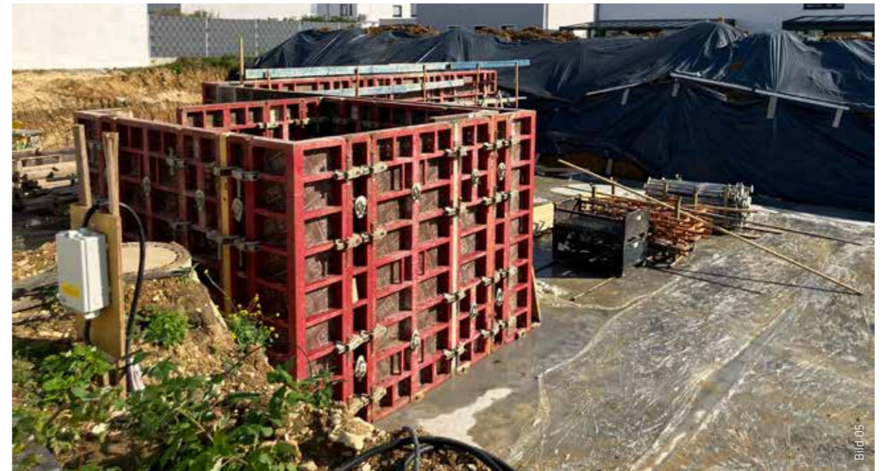
Durch die fehlende Bewehrung wurde viel Zeit beim Aufbau der Schalungen für die Wände gespart.
