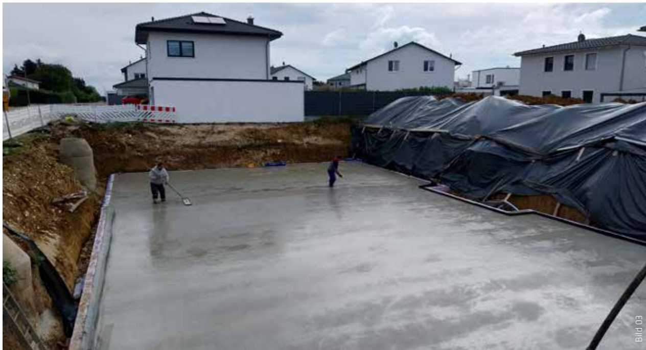
Die Bodenplatte wurde mittels Rüttelbohle verdichtet und abgezogen.
