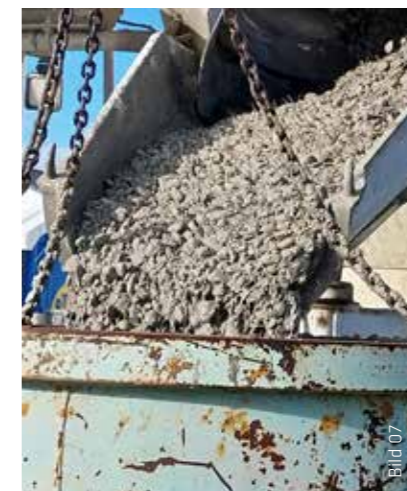
Die Polymerfasern hatten keine negativen Auswirkungen auf die Verarbeitbarkeit des Beton
