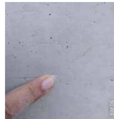
Die Polymerfasern sind an der Oberfläche kaum sichtbar.
