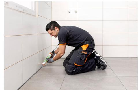
Elastisches Schließen von Boden-Wand-Fugen mit PCI Nanosil.
