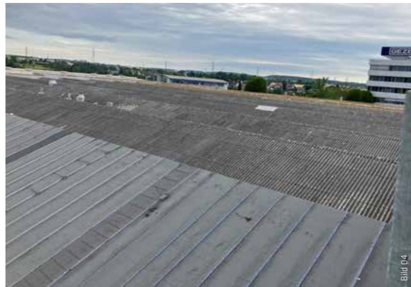
Die vorhandene Well-Eternit Abdeckung (hinten im Bild) wurde abgetragen und eine Bitumendampfsperre (vorne im Bild) aufgebracht.
