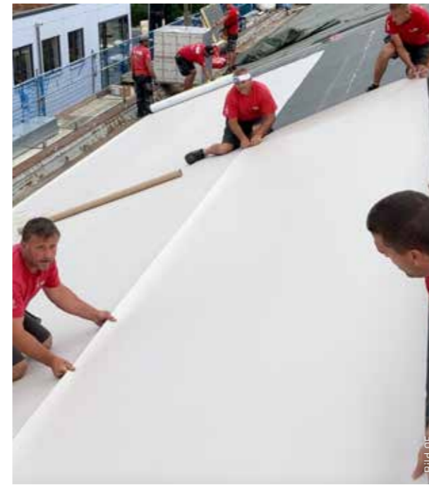
Die zwei Meter breite Dachbahn Sarnafil® 76-18 FSA wird ausgerollt und ausgerichtet.
