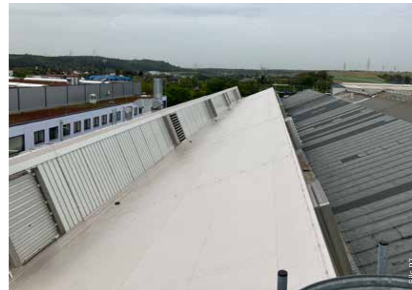
Auch die schmalen Rinnen (links im Bild) wurden mit Sarnafil® TG 76-18 FSA in Handarbeit abgedichtet.
