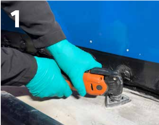
1 Mechanisches Anschleifen der Betonbodenplatte zur Entfernung von Zementschlümmen.
