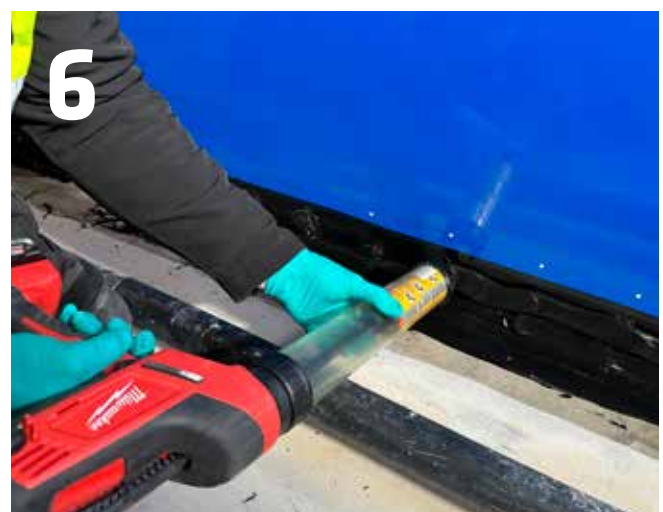
6 Abschließend Sikaflex®-403 Tank & Silo mit einer großen Düse auftragen (Kantenlänge ca. 40 mm).
