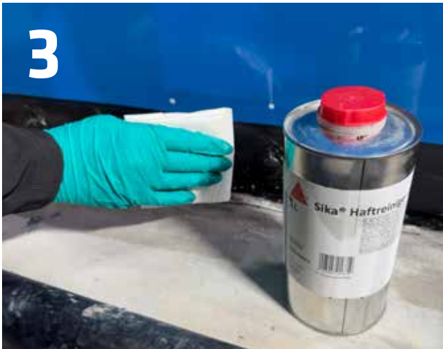
3 Die vorbereiteten Haftflächen mit Sika® Haftreiniger-1 aktivieren.
