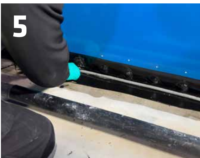
5 Sikaflex®-403 Tank & Silo auf den Behälterboden aufbringen und verspachteln. Anschließend die Sika® Rundschnur PE einlegen.
