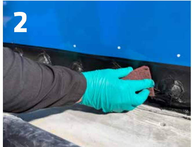
2 Haftflächen der beschichteten Behälterwand mit Schleifvlies anschleifen und den Schleifstaub trocken abwischen.
