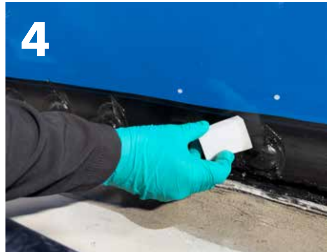
4 Sika® Primer-3 N mittels Melaminharzschwamm auf der Behälterwand mithilfe eines Pinsels auf dem Beton auftragen.
