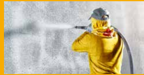
BETONSCHUTZ UND INSTANDHALTUNG
