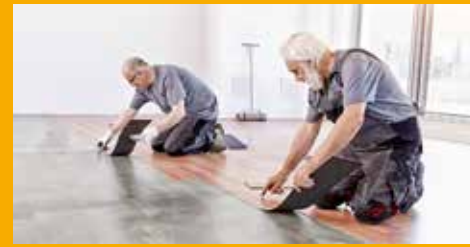
FLIESEN-, WAND- UND FUSSBODENTECHNIK
