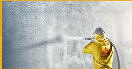
BETONSCHUTZ UND INSTANDHALTUNG
