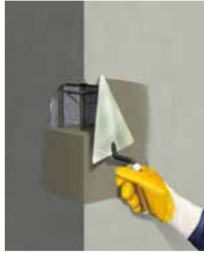
REPROFILIEREN VON BESCHÄDIGTEN ECKEN UND KANTEN
