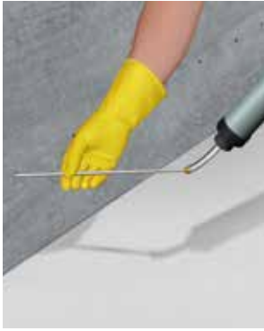
INSTANDSETZUNG VON RISSEN
