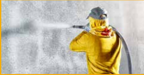
BETONSCHUTZ UND INSTANDHALTUNG
