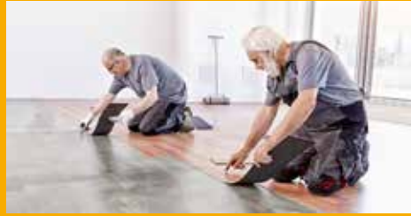
FLIESEN-, WAND- UND FUSSBODENTECHNIK
