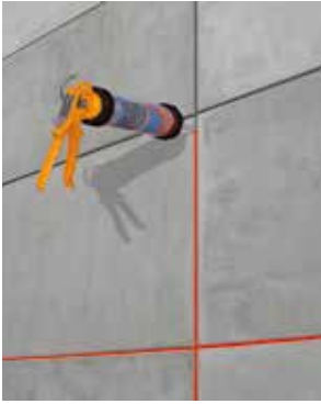
ABDICHTUNG VON BEWEGUNGSFUGEN
