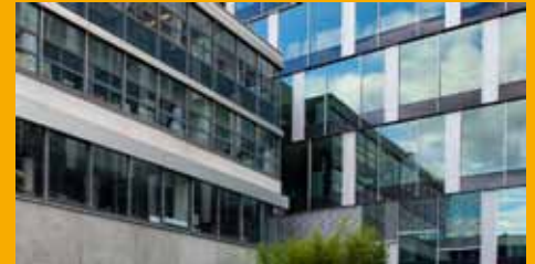
KLEBEN UND DICHTEN IM FASSADENBEREICH
